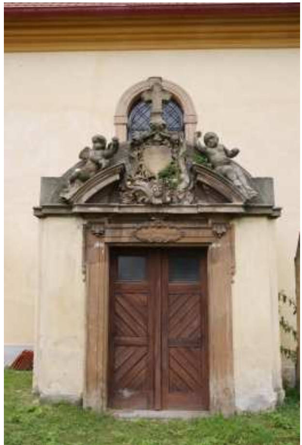
9. Dru•ec, kostel Nanebevzetí Panny Marie, detail portálu ji•ní předsíně
