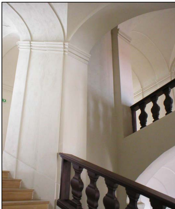
12. Zrekonstruované schodiště v kolejní budově.
