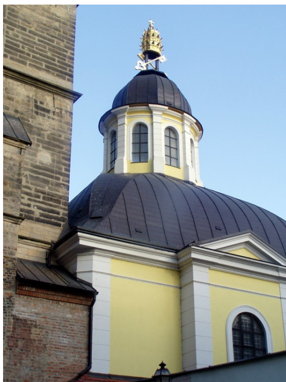
Hradec Králové, kaple sv. Klimenta, 18. století, pohled ze severozápadu.
