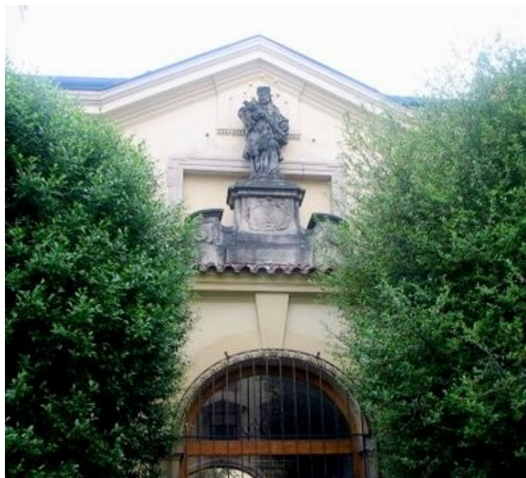
Hradec Králové, bývalý seminární kostel sv. Jana Nepomuckého, dnes Městská hudební síň, 1714, pohled z jihu.
