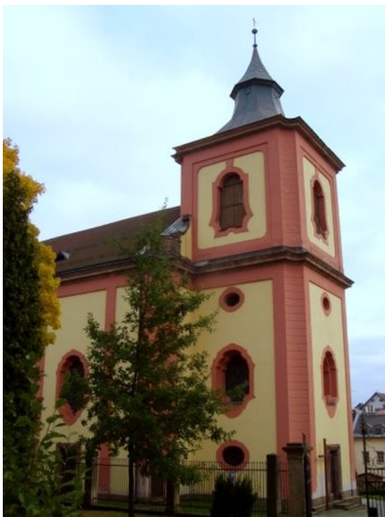
Jilemnice, kostel sv. Vavřince, 18. století, pohled z jihu.
