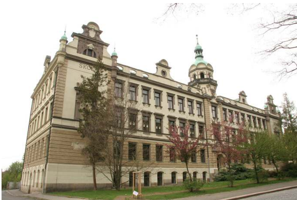
4. Obecná a měšťanská škola chlapecká , ul. Skálova, č.p. 600, současný stav, jižní průčelí
