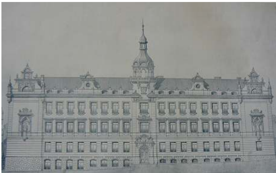
5. Obecná a měšťanská škola chlapecká , ul. Skálava, č.p. 600, dobová reprodukce dokumentace, jižní průčelí
