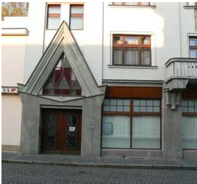
17. Vila Ladislava Ducháčka, ul. U Nádraží, č.p. 1294, současný stav, detail jižního portálu
