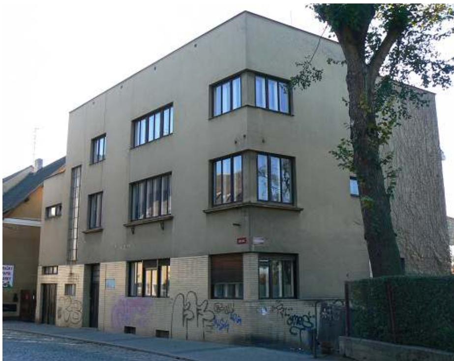
52. Rodinný dům Dr. Václava Šolce, ul. Skálova, č.p. 917, současný stav, pohled od severovýchodu
