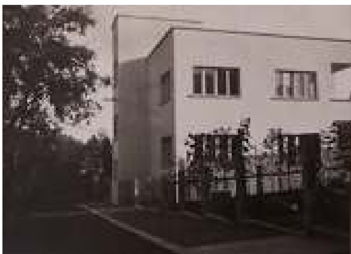
22. Vila č.p. 817, ul. Partyzánská, dobová fotografie, pohled od jihu
