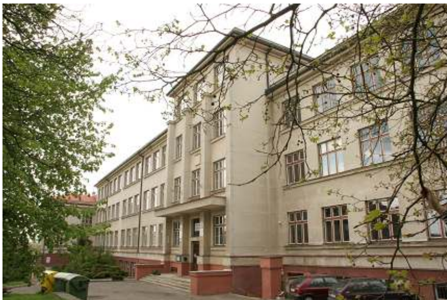
31. Státní reálná škola v Turnově, ul. Jana Palacha, č.p. 804, současný stav, pohled od jihu
