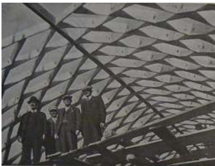
55. Husův sbor , ul. Žižkova, č.p. 665, dobová fotografie, Vladimír Krýš pod lamelovou střechou
