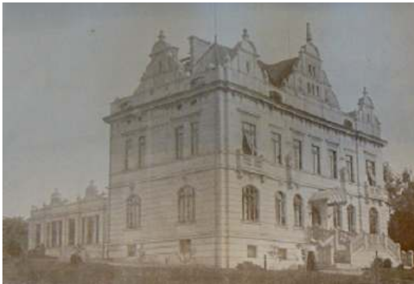
1. Vila Jana Jiránka , Sobotecká, č.p. 595, dobová fotografie, pohled od severozápadu
