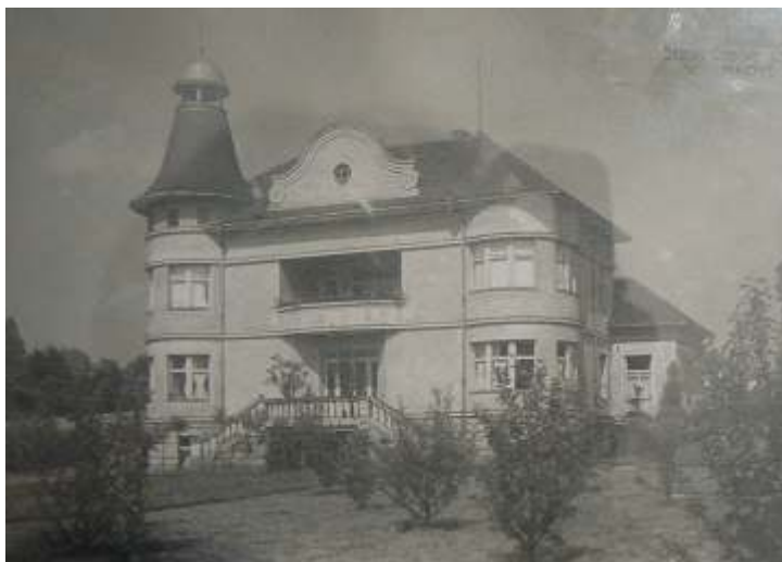
54. Husův sbor , ul. Žižkova, č.p. 665, dobová fotografie původního stavu, pohled od západu
