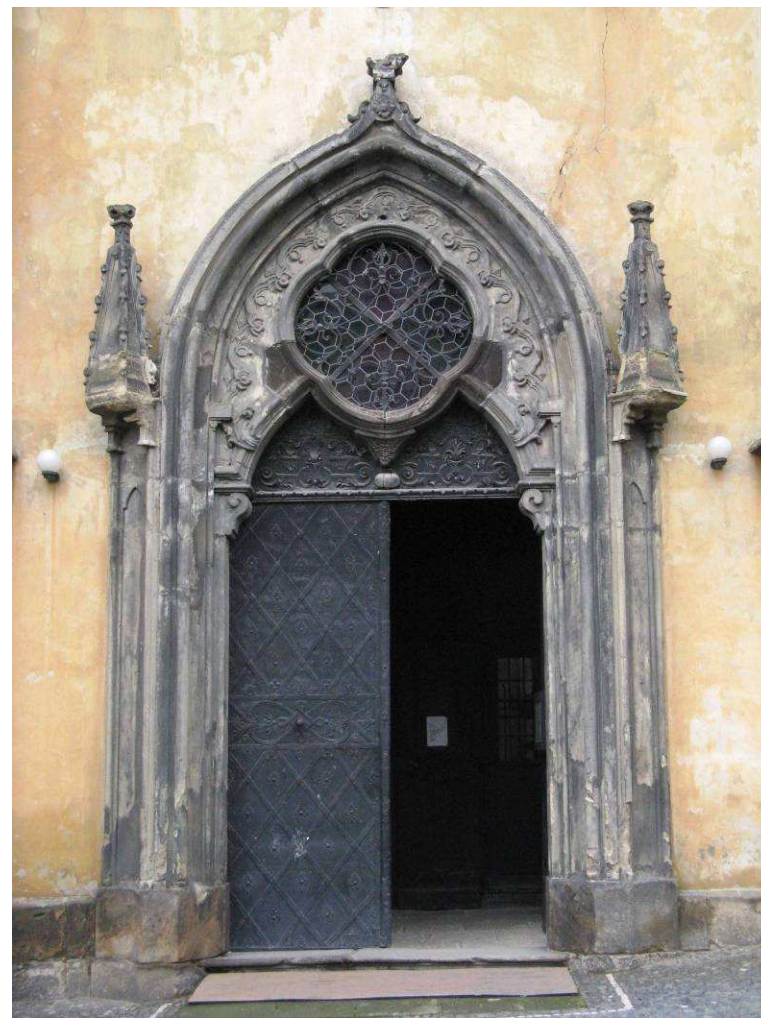
Obr. č. 7. Západní portál kostela
