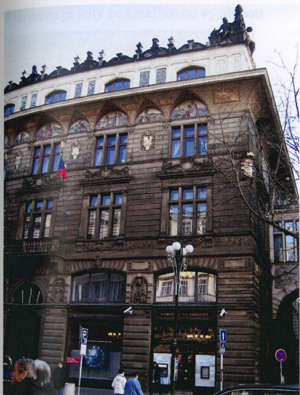
74) Zemská banka, Na Příkopě 20/858, Praha
