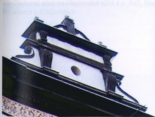
66) Štít na domě na rohu ulic Na Poříčí a Havlíčkova, Praha
