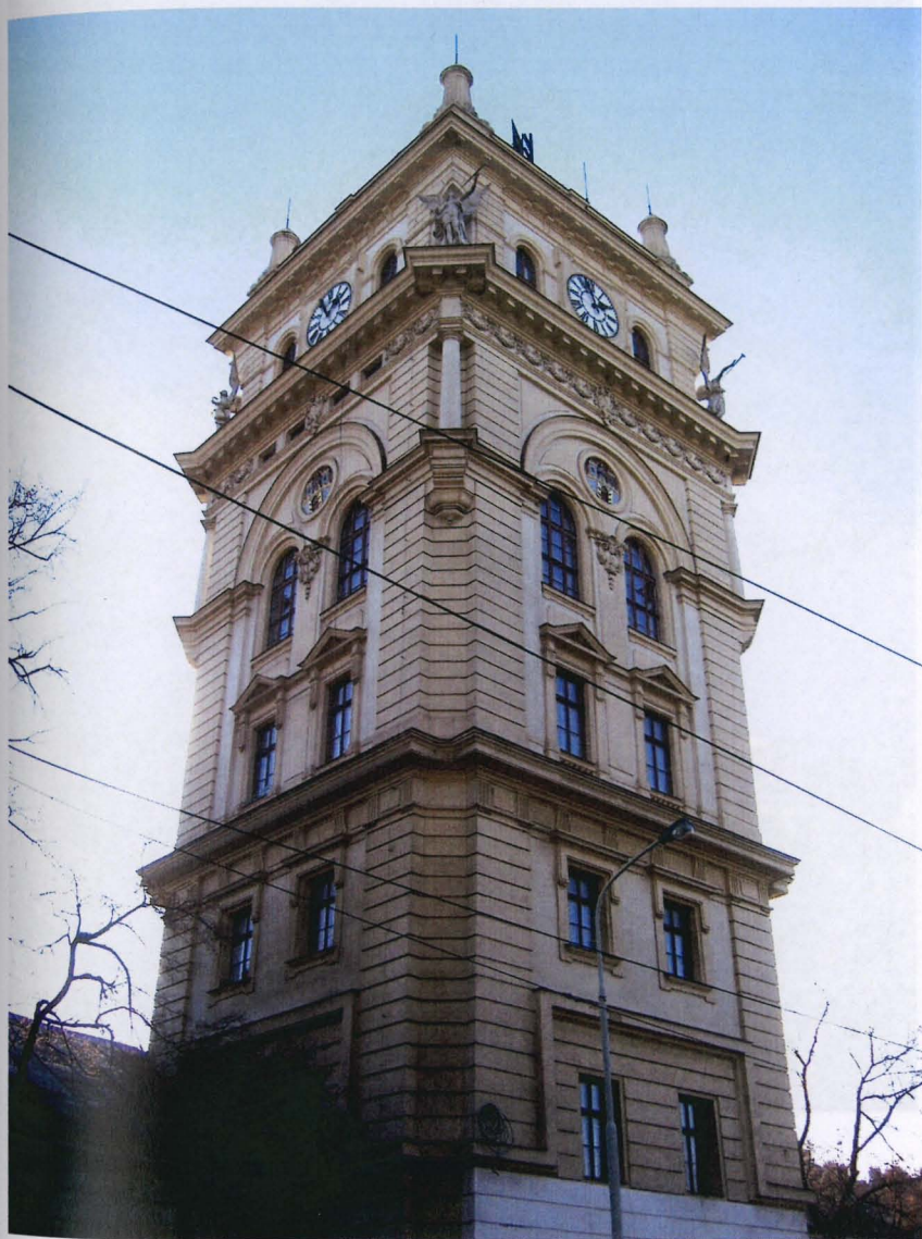
94) Vinohradská vodárna, Praha
