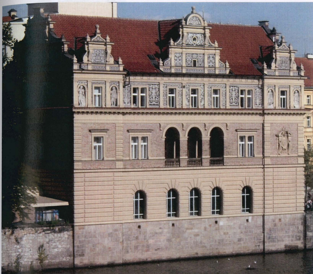
64) Staroměstská vodárny, Praha
