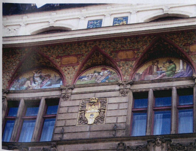
75) Zemská banka, Na Příkopě 20/858, Praha
