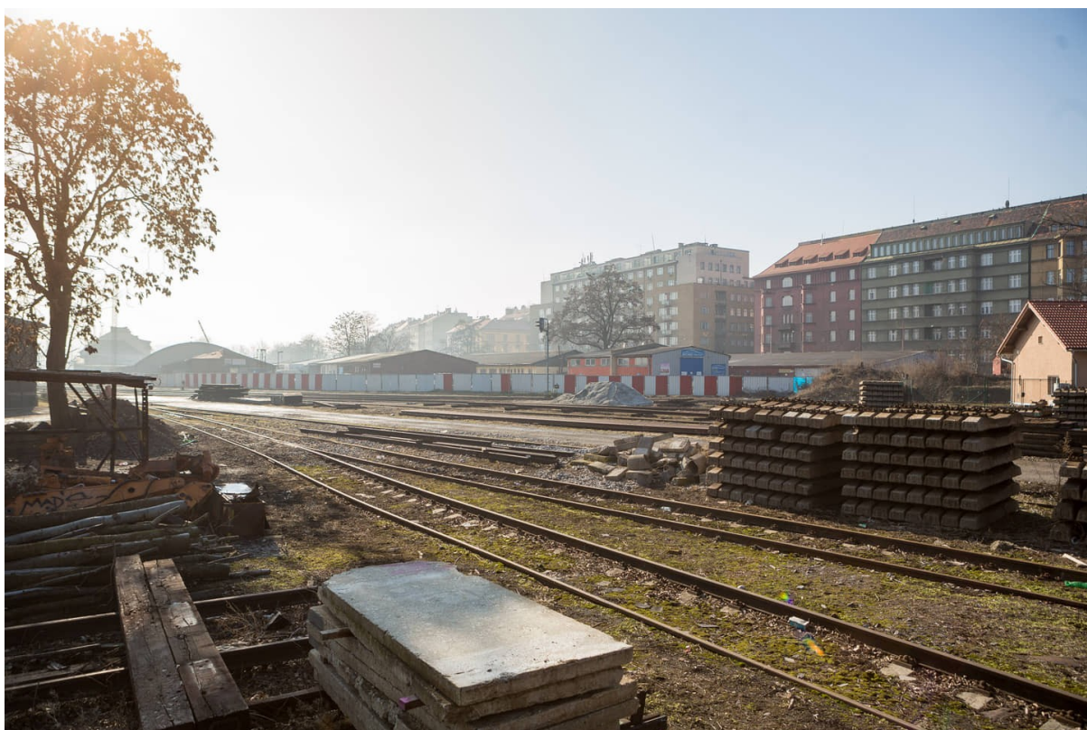
Obr. 4.: Stav území před zahájením stavby železniční trati a nádraží Bubny. Zdroj IPR Praha (2021)
