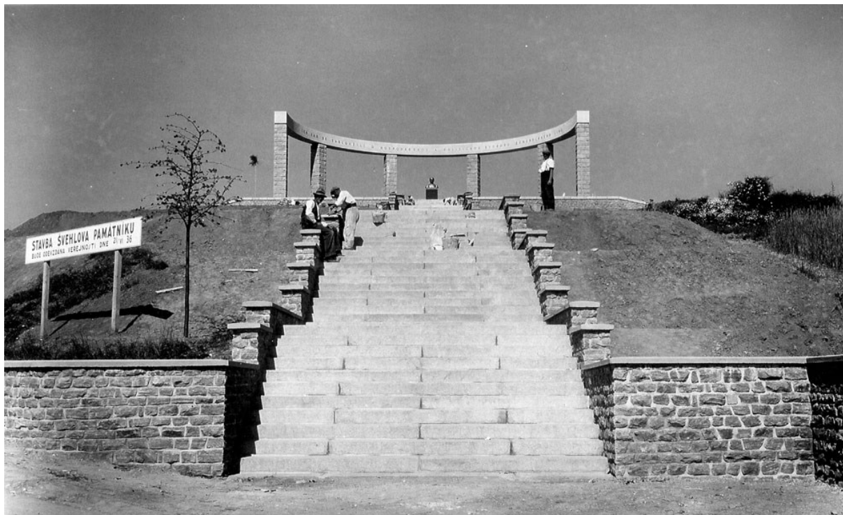
Příloha č. 292: Švehlův památník ve Ždánicích krátce po dokončení 292
