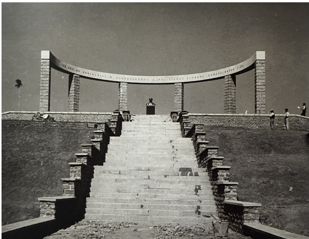
Příloha č. 293: Švehlův památník ve Ždánicích krátce po dokončení 293
