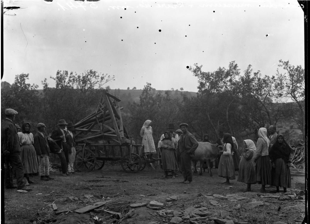
57. Vesničané pomáhající v rozebírání a dopravě dřevěných konstrukcí na nádraží.
