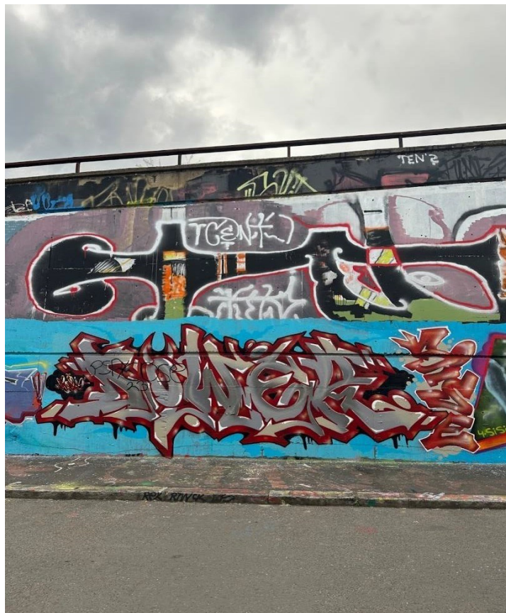
Obr.21 - Piece na fasádě mostu, ulice Železničářů, 15.6.2023, Sára Perutková
