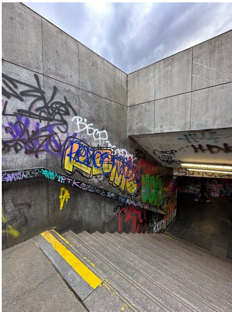
Obr.18 - Vstup do podchodu mezi autobusovým nádražím a metrem Nádraží Holešovice, piece, tagy, Sára Perutková, 15.6.2023
