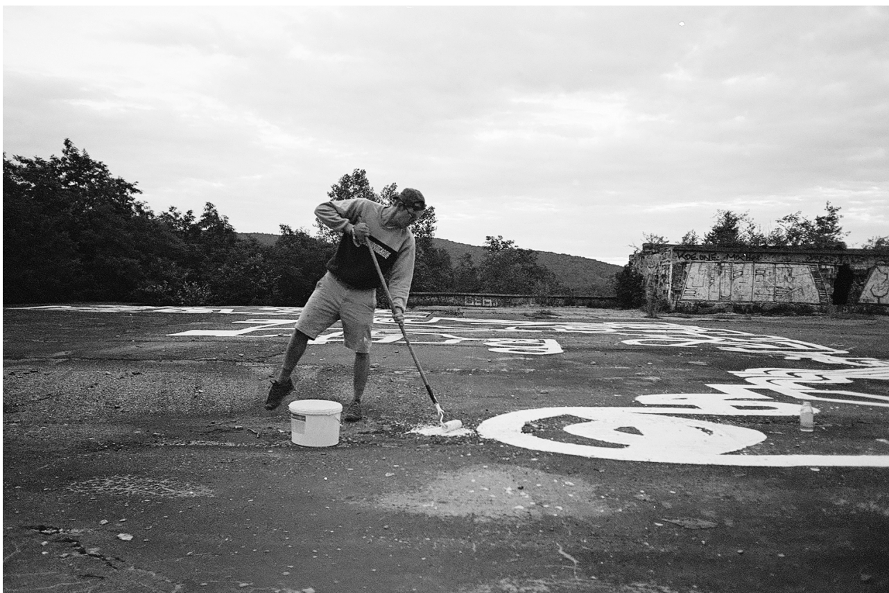
Práce na střeše
