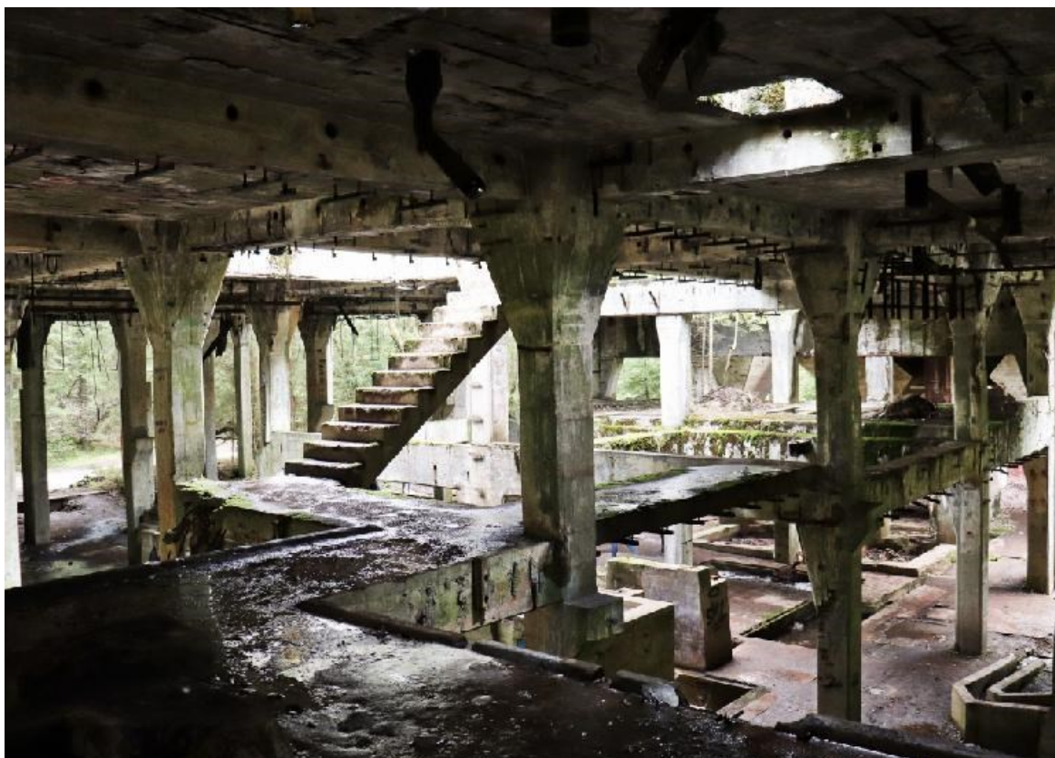
12. Aneta Vacková, průhled skeletem cínového dolu, betonová konstrukce obrostlá mechem a v pozadí les, Rolava, duben 2023.
