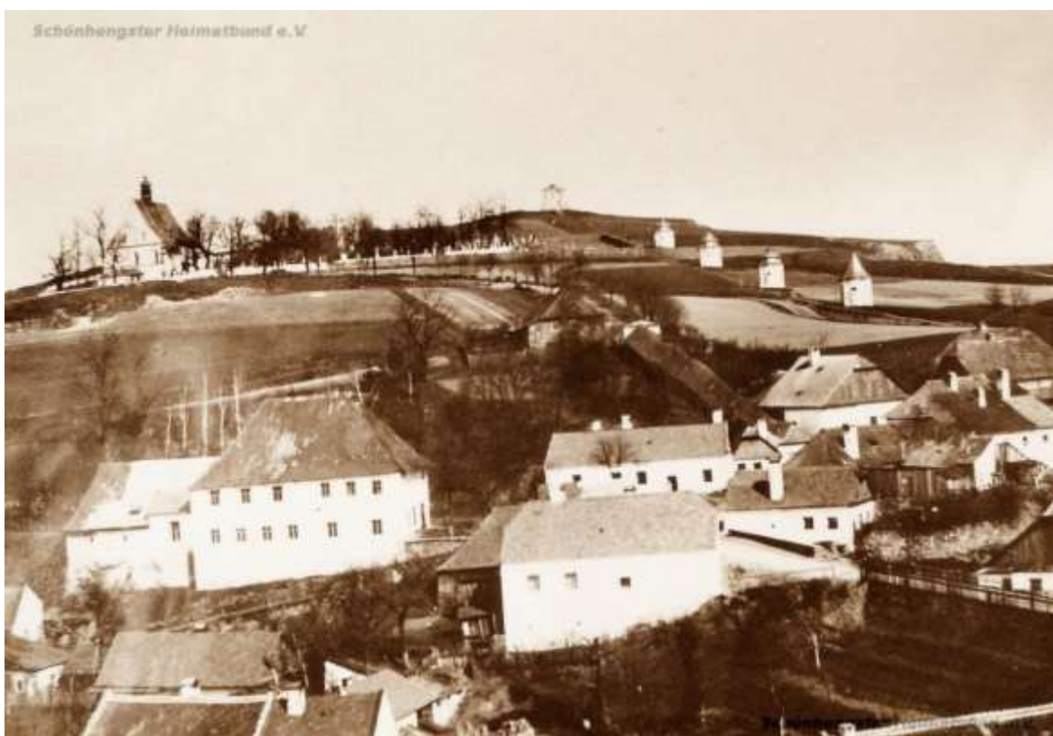
4. Moravská Třebová, Křížový vrch s Pašijovou cestou, schody mrtvých a hřbitovním kostelem, pohled od západu
