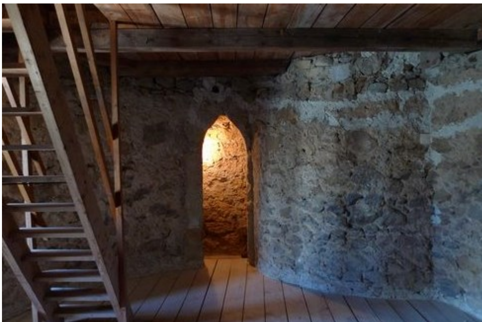
Obrázek 33: Lemberk, věž, hrotitý portál na schodišti vedoucím v síle zdi
