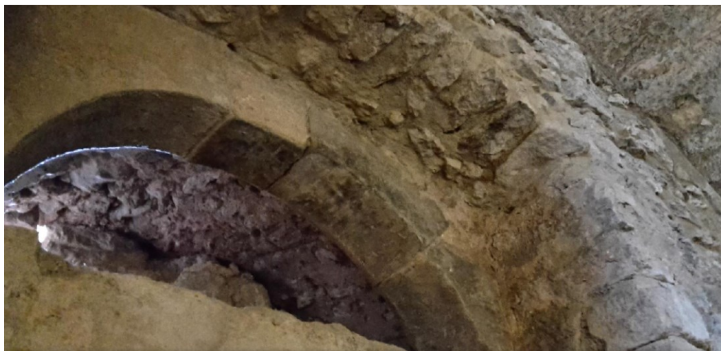
Obrázek 22: Český Dub, johanitská komenda, interiér, jižní zeď, detail raně středověkého zaklenutí pův. portálu
