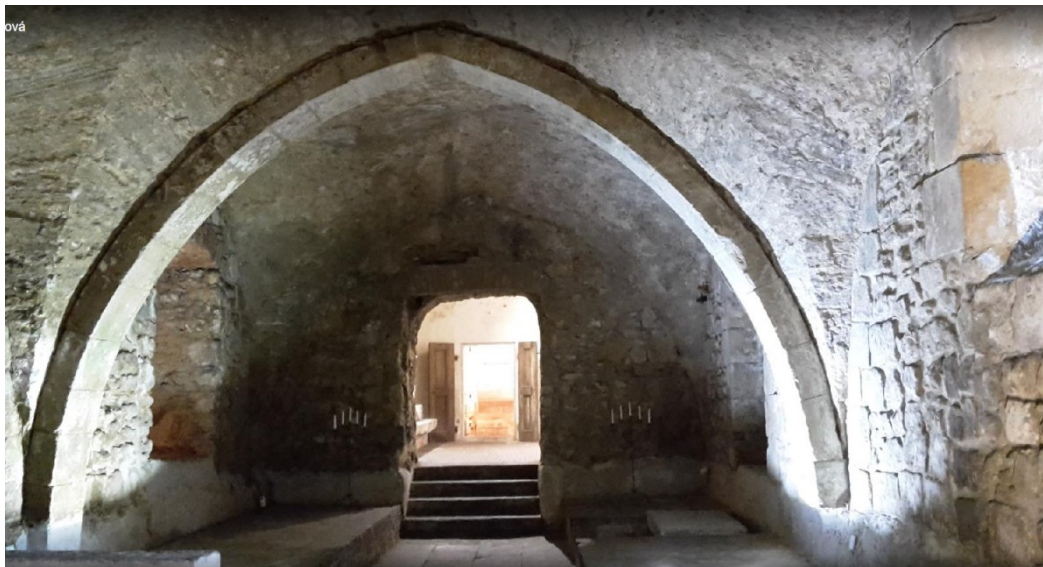
Obrázek 24: Český Dub, johanitská komenda, interiér, cellárium, pohled na severní stěnu
