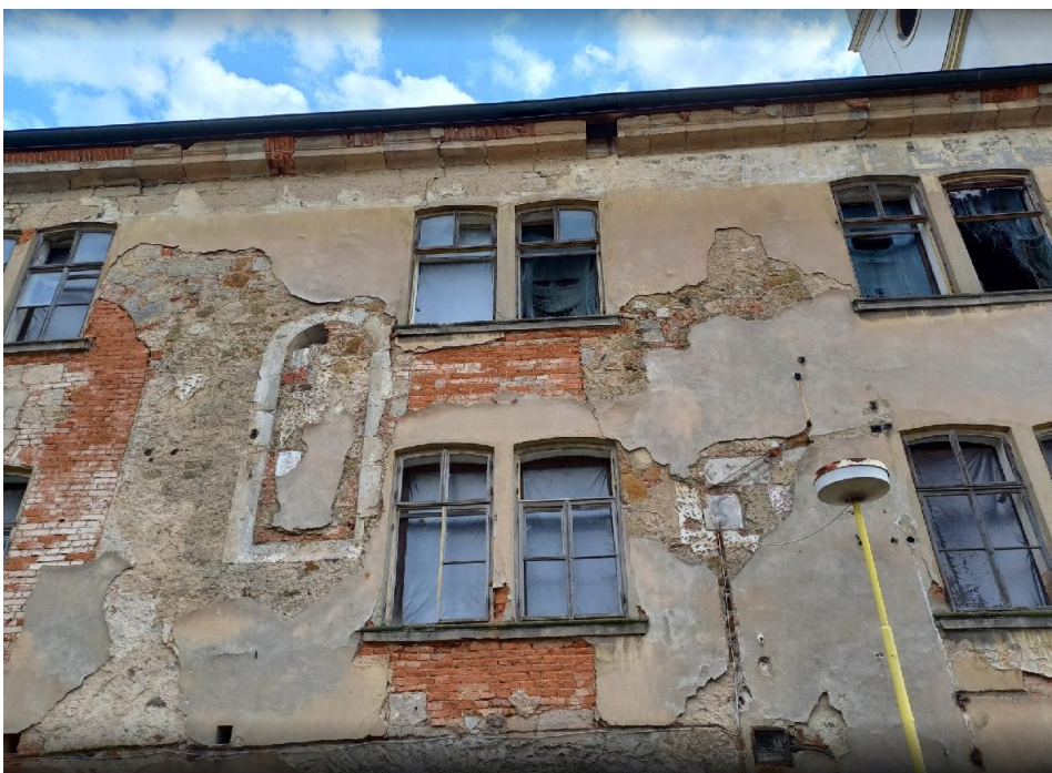
Obrázek 28: Jablonné v Podještědí, farní kostel, severní stěna
