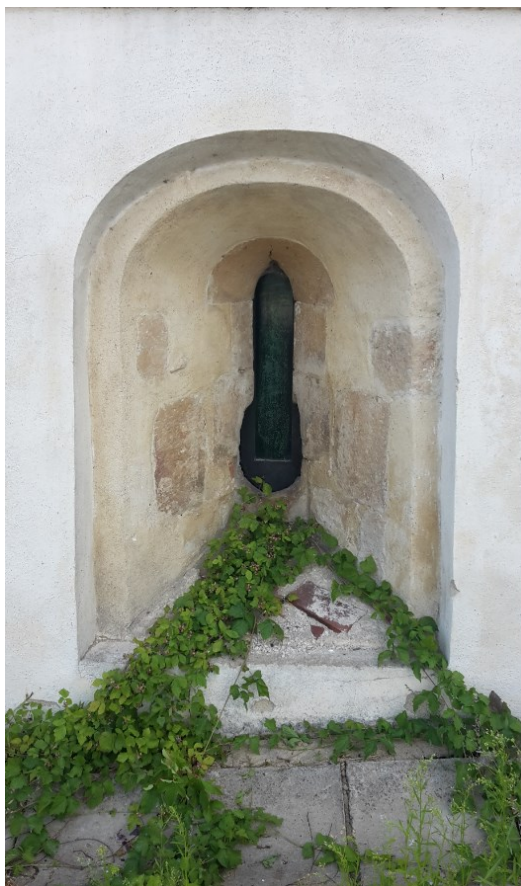
Obrázek 20: Český Dub johanitská komenda, východní zed', štěrbinové okno později upraveno rozšířením spodní části
