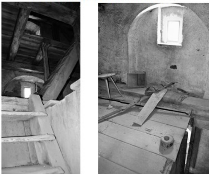
Foto 1/20 a 21: kostel sv.Kateřiny, HSK: schody na věž, kruhový otvor pro lano od zvonu; 12.5.2018, vit.
