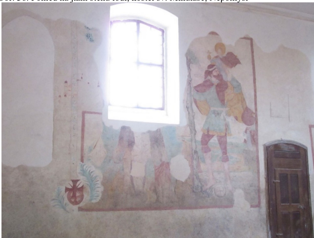
Obr. 36. Pohled na jižní stěnu lodi, kostel sv. Mikuláše, Nepomyšl
