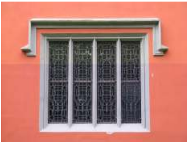
23. Hrádek u Nechanic, severovýchodní křídlo, detail okna, pohled z nádvoří strany.
