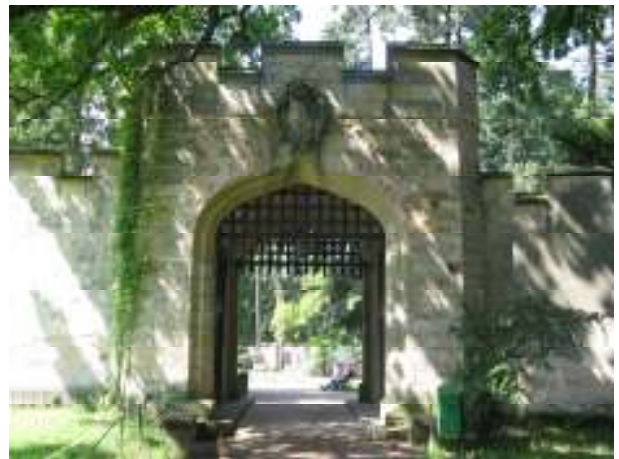
24. Hrádek u Nechanic, vstupní brána do zámeckého parku, pohled od jihu.
