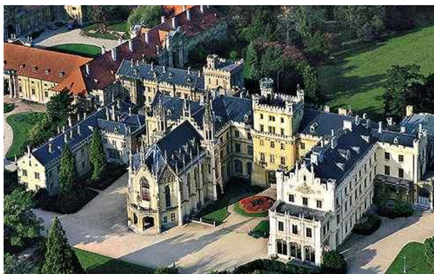
15. Zámek Lednice, neogoticky přestavěn v letech 1846–1858, letecký pohled.
