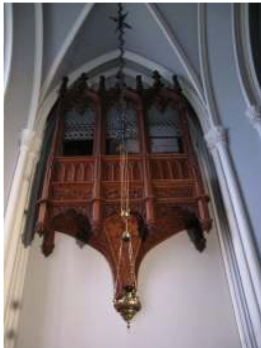
58. Hrádek u Nechanic, zámecká kaple, panská oratoř.
