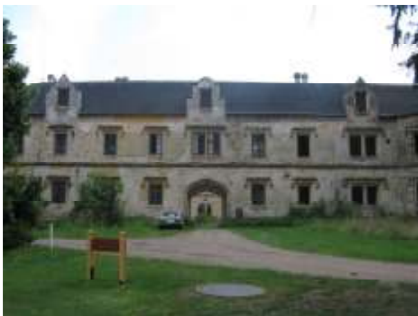
62. Hrádek u Nechanic, komplex hospodářských budov východně od zámku, pohled od severu.
