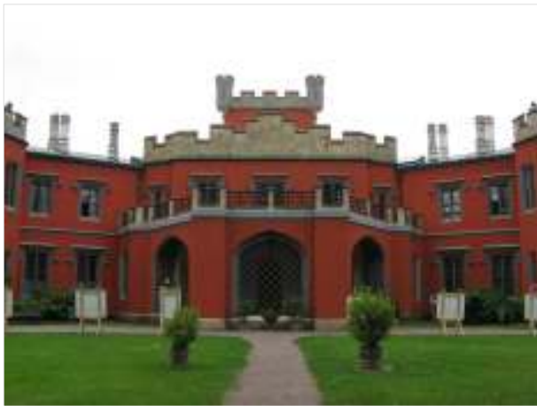
21. Hrádek u Nechanic, ústřední zámecká budova s krytým podjezdem, pohled od severu.
