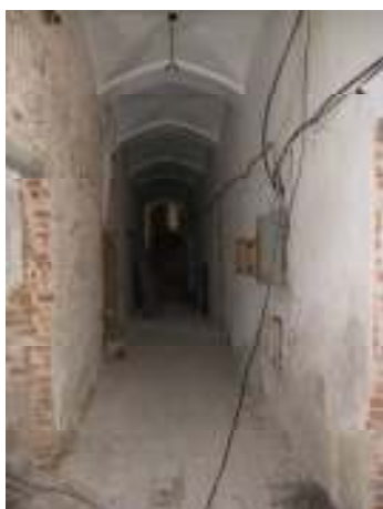
64. Hrádek u Nechanic, chodba spojující severovýchodní křídlo zámku s hospodářskými budovami.
