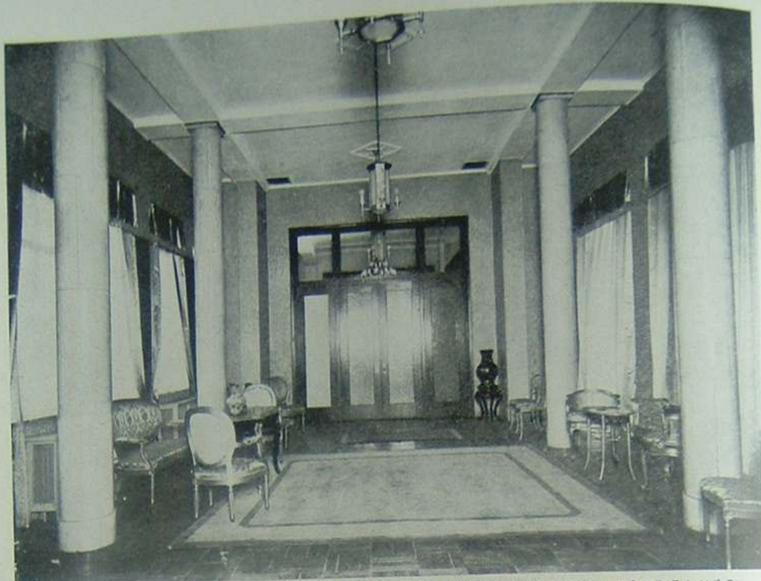
16.第一應接室。家具は何れも舊大使館のものである。之等の家具や照明器具が如何に建物と不調和であるかが分る。窓のカーテンは銀色と黄色である。The first reception room.
