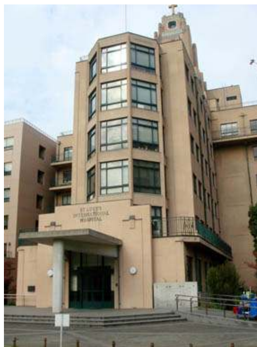
Obr. 20 Detail vstupu do nemocnice
