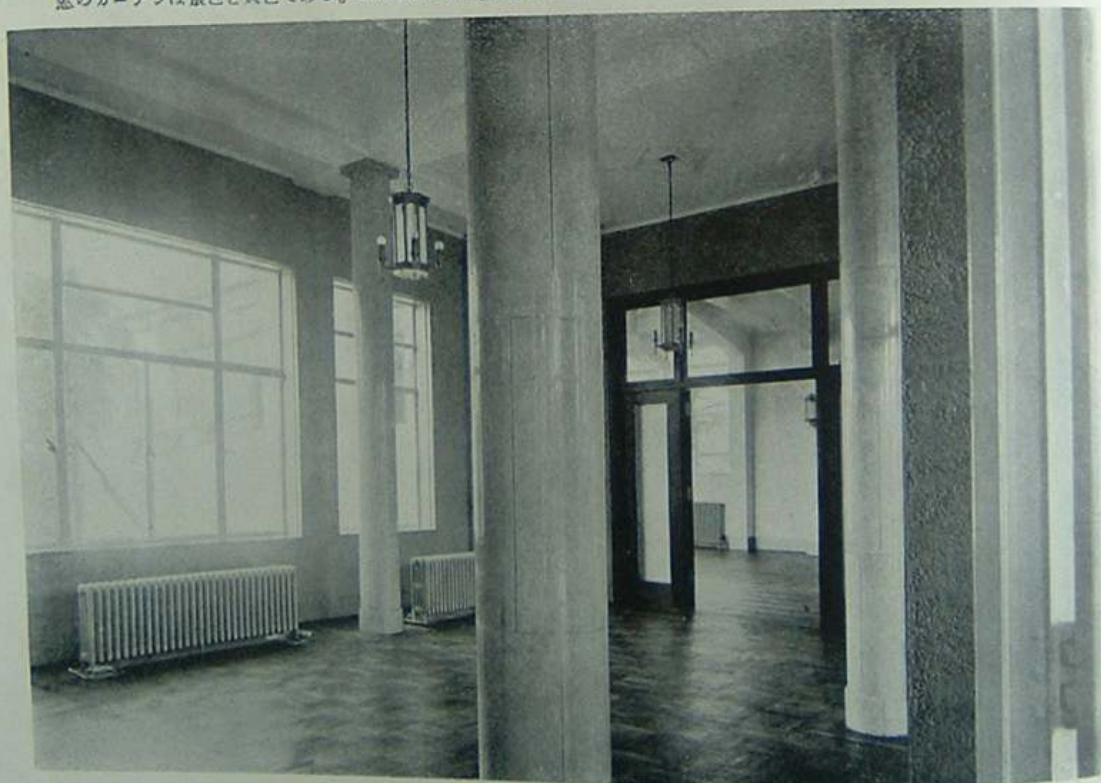
17.第一應接室。上と同じであるが家具の入る前である。上の写真と比べて見て感じの違ふのに驚くのである。Same room with out furnitures.
