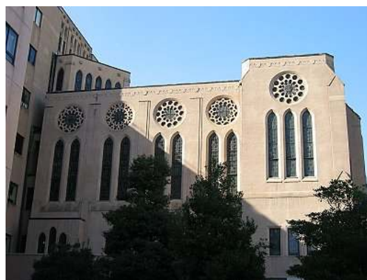
Obr. 19 Detail kaple nemocnice sv. Lukáše
