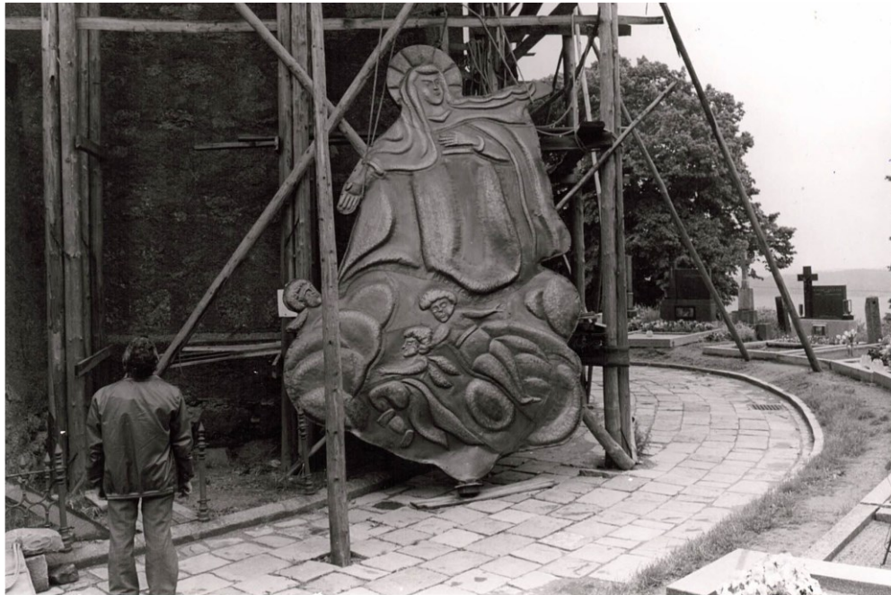
B) Detail nové měděné plastiky těsně před vyzdvižením na věž kostela
