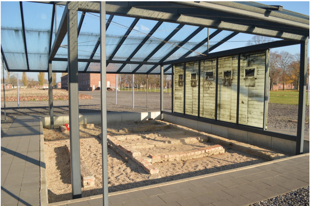
Der ehemalige Arrestbunker (Neuengamme, November 2018)
