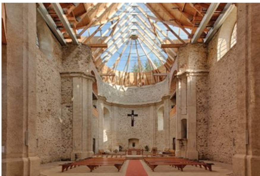
22. Neratov , Kostel Nanebevzetí Panny Marie, rekonstrukce střechy 2007
