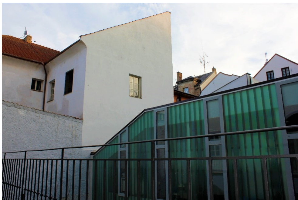
19. Kolín , Regionální muzeum v Kolíně, rekonstrukce pod vedením INARCH s. r. o. Ireny Hrabínové 2014–2018, pohled z terasy na dvůr
