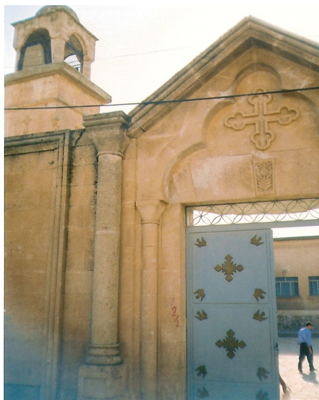
16. Vchod do nádvoří kostela mor Šimuni v Midyatu. Autor: Rudolf Eisenhammer, 2003.
