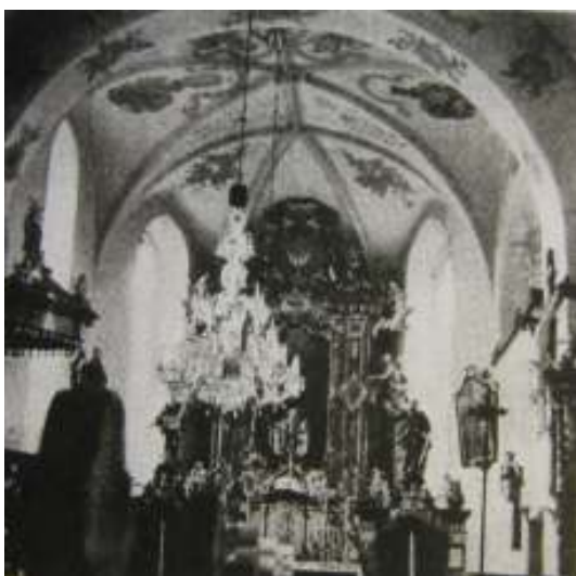
16. Dolní Olešnice, kostel sv. Jakuba, 1589, klenba presbytáře.
