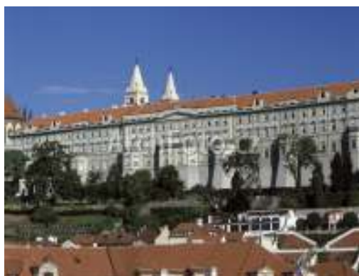
5. Praha, Rožmberský palác, dnes ústav šlechtičen, 1545 – 1560, pohled od jihu.
