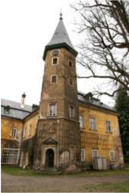
42. Dolní Zámky u Olešnice, zámek, 1595 – 1607, pohled od východu.
