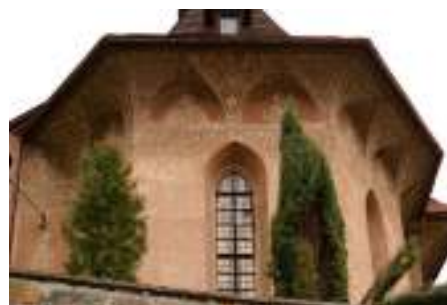
15. Dolní Olešnice, kostel sv. Jakuba, 1589, polygonální zaklenutí kněžiště, pohled od severu.
