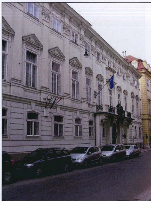
Franz Anton Hillebrandt, Wien, Uherská dvorská kancelář, 1783-85
