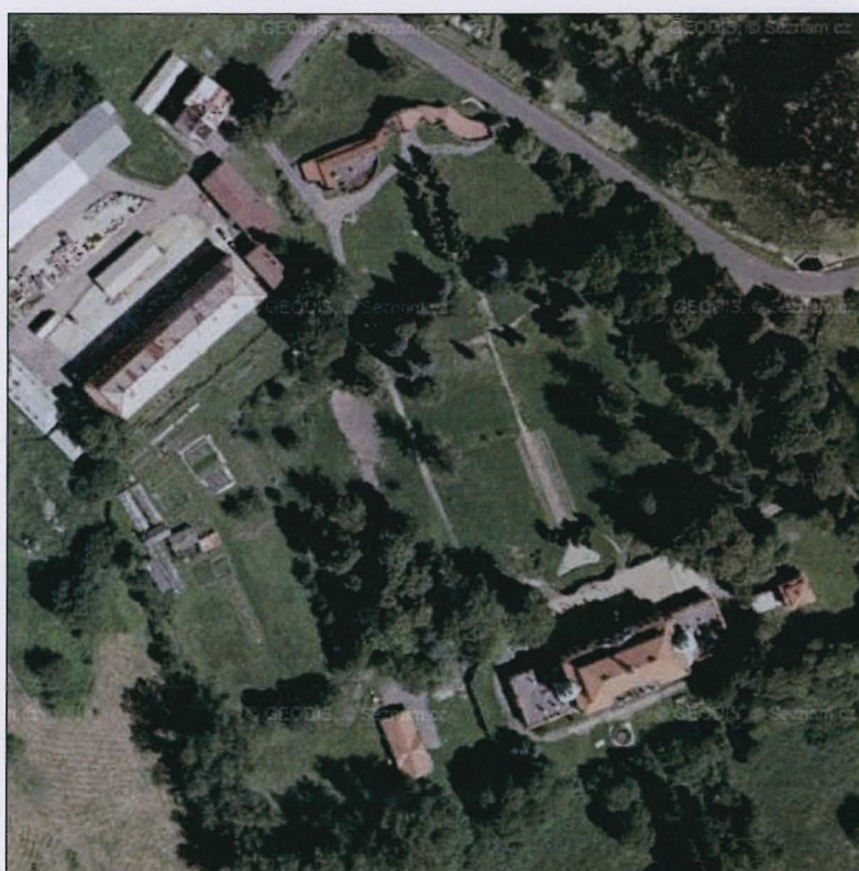
Nový Falkenburg, zámek, letecký pohled
