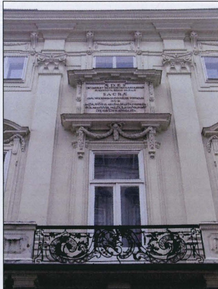
Franz Anton Hillebrandt, Wien, Uherská dvorská kancelář, 1783-85
