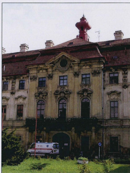
Anton Haffenecker, Měšice, zámek, hlavní zámecká budova, detail středního risalitu, 1767-75
