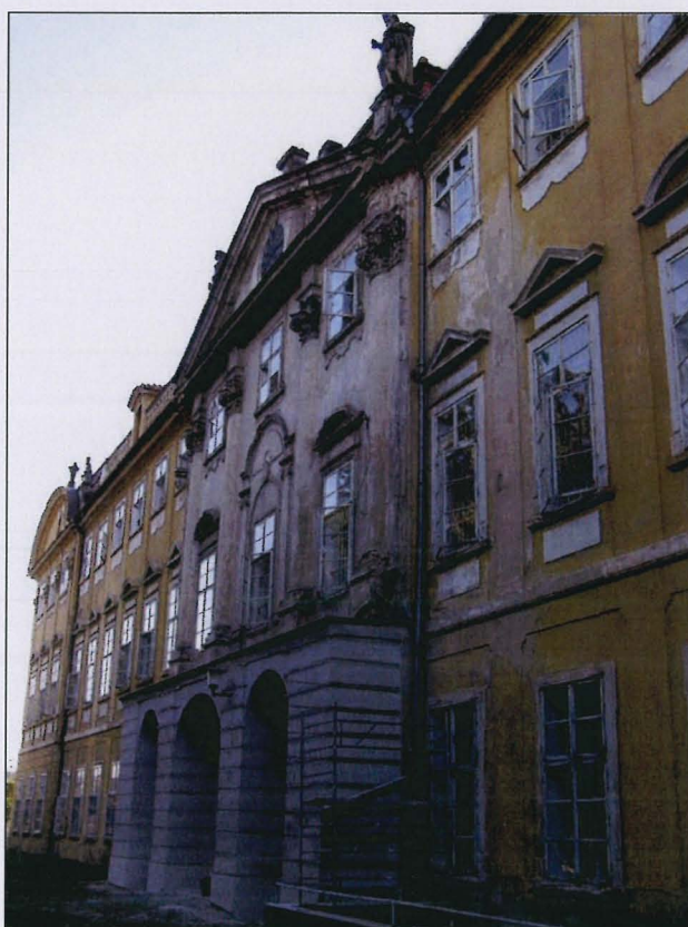
Anton Haffencker (?), Horní Beřkovice, zámek, zahradní průčelí, přestavba před 1773
