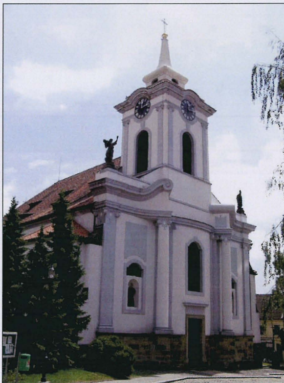
Jan Josef Wirsch, Český Brod, kostel sv. Gottharda, přestavba 1765-72
