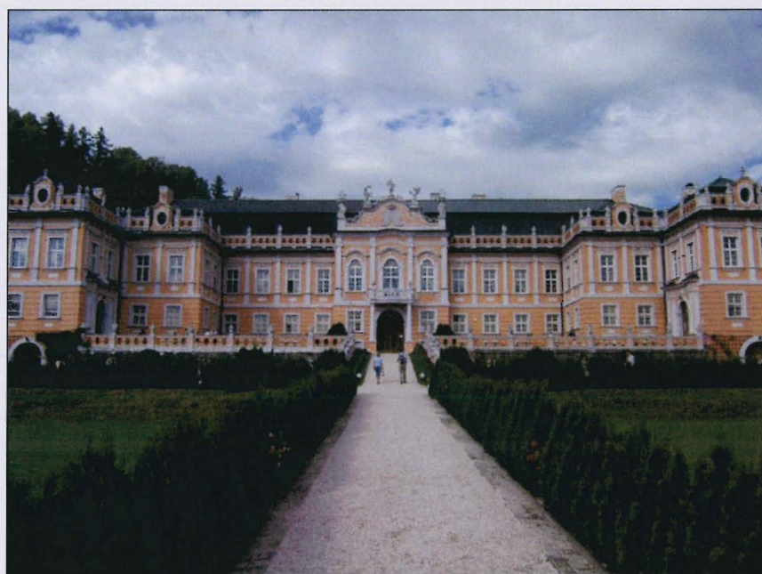
Jan Antonín Harbuval-Chamaré – Josef Jäger, Nové Hrady, zámek, hlavní průčelí, přestavba kolem 1777
