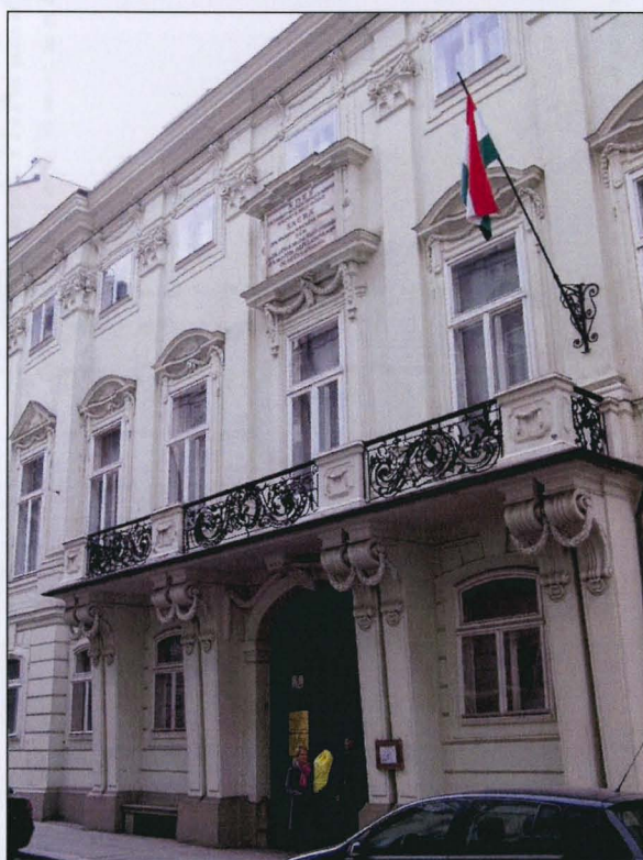
Franz Anton Hillebrandt, Wien, Uherská dvorská kancelář, 1783-85
