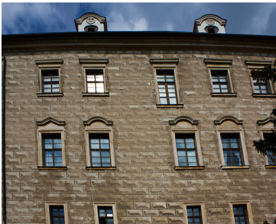
2. Zámek Benátky nad Jizerou, jižní strana západního křídla, pohled na vnější fasádu se sgrafitem psaníčkového typu.
