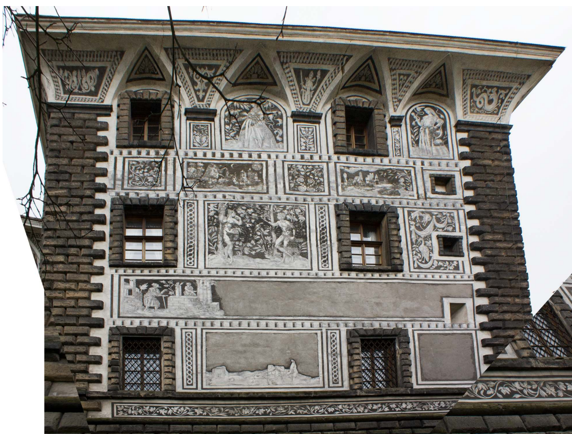
20. Sgrafitová výzdoba severní strany severozápadního bastionu.
