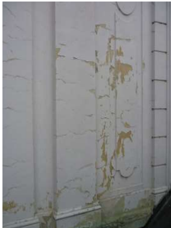
28. Detail fasády tamburu na kostele sv. Mikuláše na Staroměstském náměstí (Praha, 1732-1737, Kilián Ignác Dientzenhofer): ukázka odlupujícího se latexového nátěru (r. 2014)
