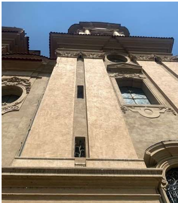
30. Detail současné fasády kostela sv. Mikuláše na Staroměstském náměstí (Praha, 1732-1737, Kilián Ignác Dientzenhofer): ukázka střídání omítek pevně utahovaných a štukovaného architektonického členění
