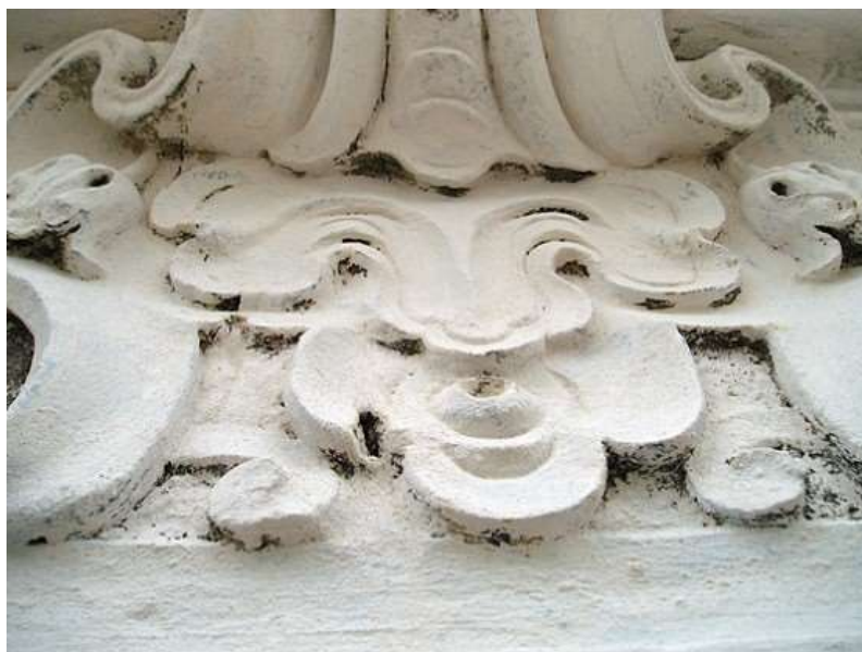
25. Detail fasády Lužického semináře seminář (Praha, 1726-1728, Kilián Ignác Dientzenhofer): detail štukové výzdoby před rekonstrukcí v r. 2005
