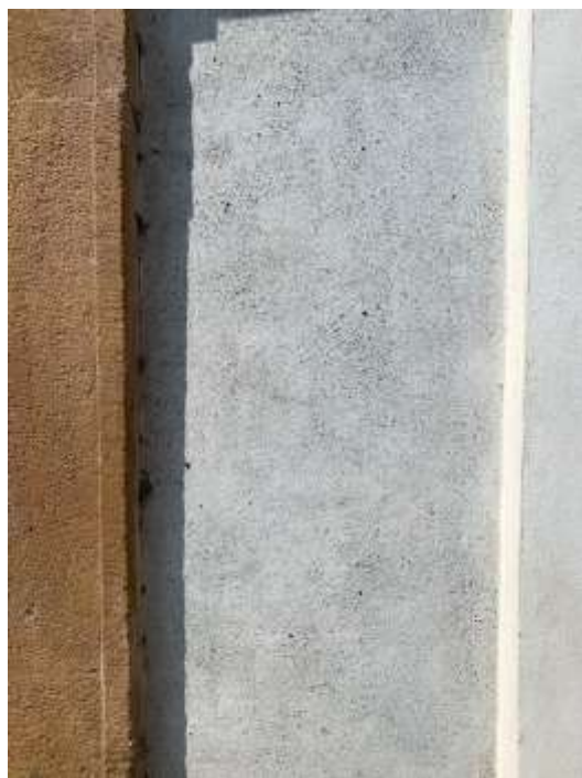
21. Detail fasády Toskánského palác (Praha, 1689-91, Jeana Baptisty Mathey): detail omítky s rozdrčeným šedo-modrým sklem
