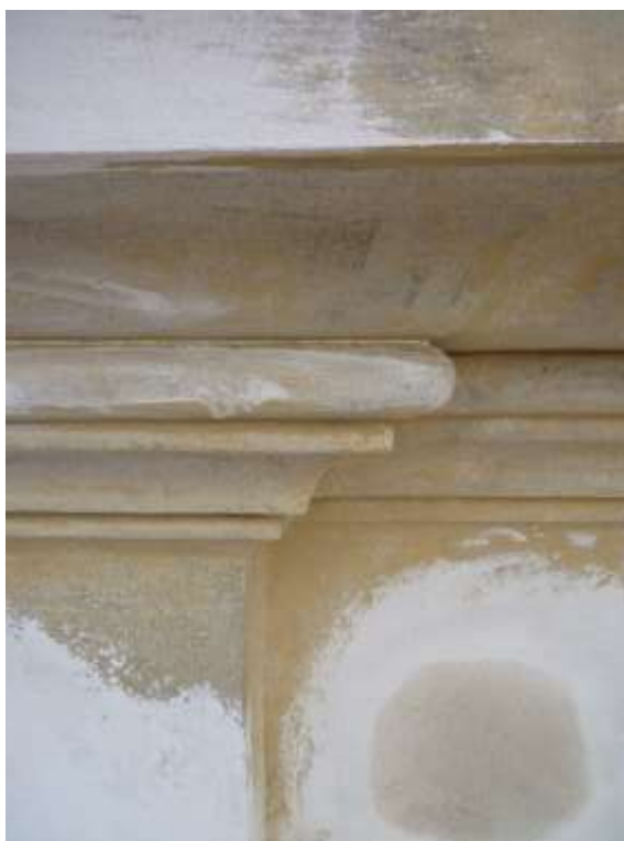
31. Detail kostela sv. Jana Nepomuckého na Skalce (Praha, 1730–1738, Kilián Ignác Dientzenhofer): detail po očištění omítky
