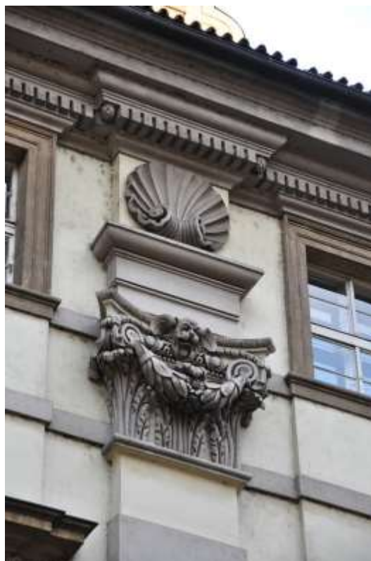
13. Národní knihovna, západní fasáda při Křižovnické ulice (Praha, 1654–1656, Carlo Lurago): fasáda s nátěrem silikátové barvy
