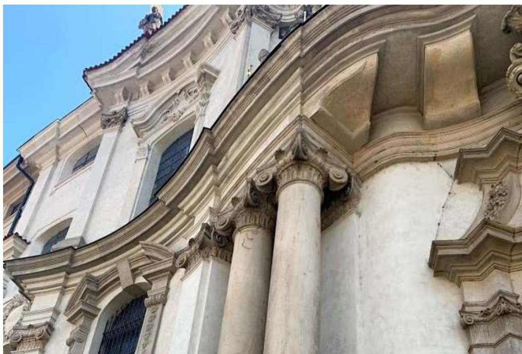
36. Detail průčelí kostela sv. Mikuláše na Malé Straně (Praha, 1703-1755, Kryštof a Killián Ignác Dientzenhofer): monochromní nátěr scelující omítané i štukované prvky s barevností prvků kamenných
