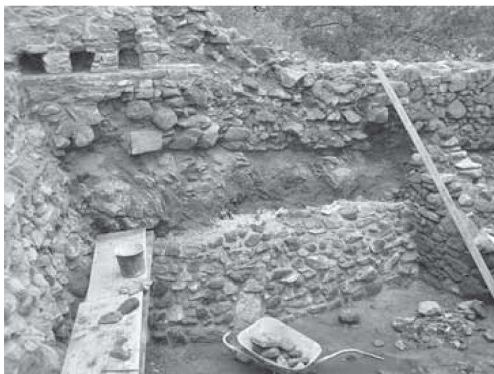
32. Brtnice , hrad Rokštejn, konec 13. století, přizdívka k ochraně skalního podloží
