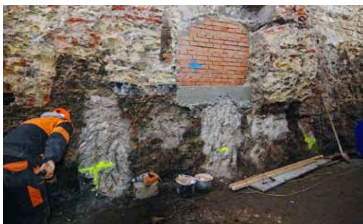
27. Praha , Pinkasův palác, 17. století, zpevňování základů pomocí tryskové injektáže
