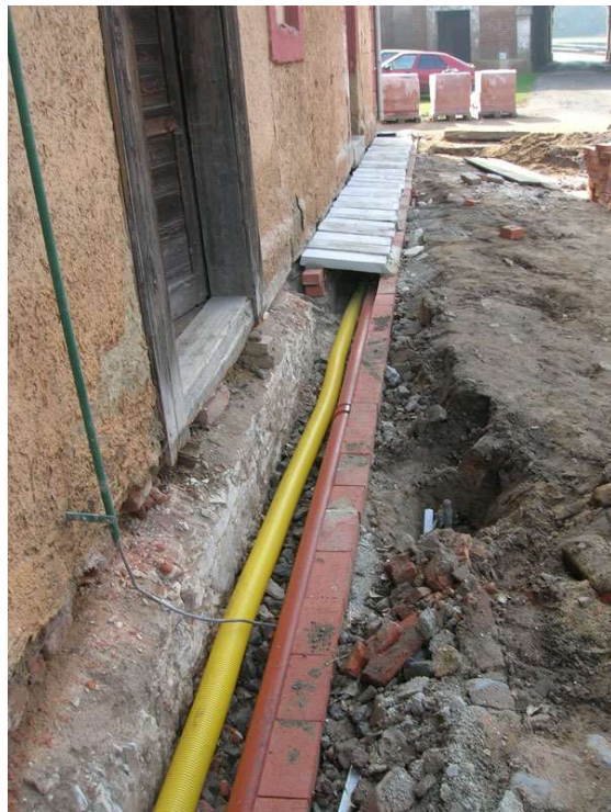
35. Terezín , konírna Malé pevnosti, konec 18. století, průběh stavby ventilačního kanálu
