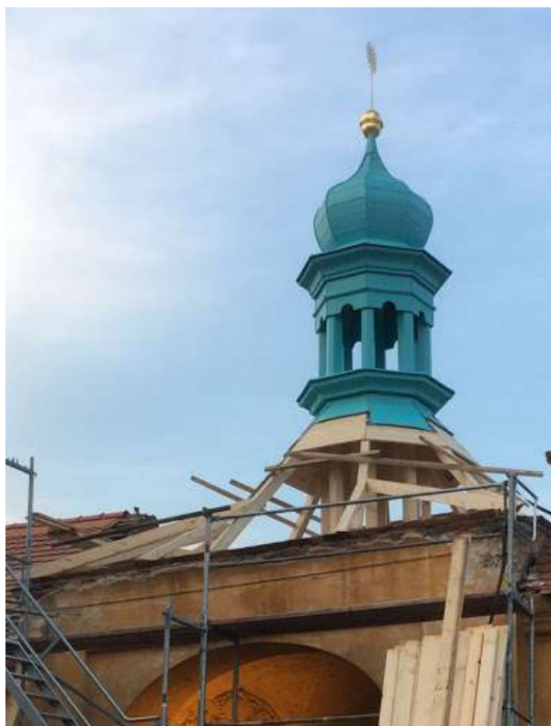
21. Horní Police , ambit, 1719–1724, rekonstrukce jižní věžičky
