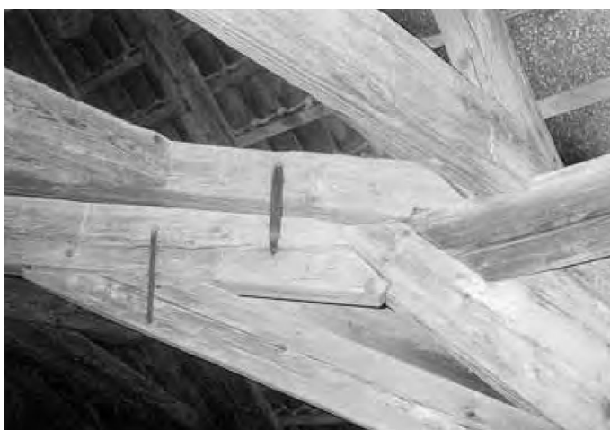
7. Ledčice , kostel sv. Václava, 1738–1745, zajištění trhlin trámů pomocí železných kramlí
