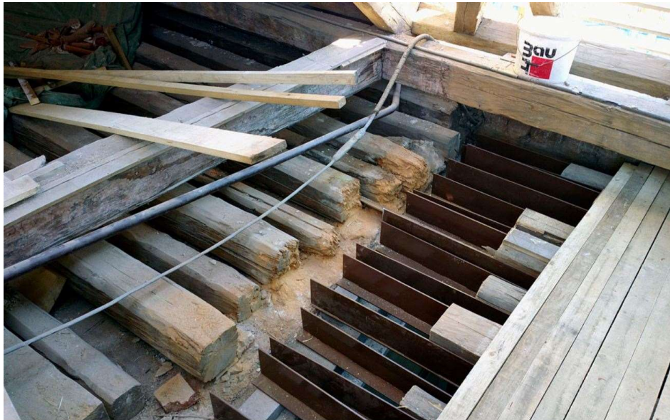
14. Praha , Pálffyovský palác, 1712, osazování zhlaví trámů stropní konstrukce do ocelových konzol
