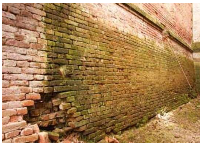
30. Terezín , Malá pevnost, konec 18. století, narušené zdivo jižního průčelí
