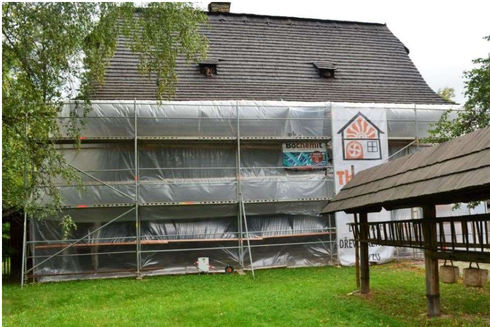
11. Rožnov pod Radhoštěm, radnice, 1770, příklad termosanace, izolace budovy termoizolační folií
