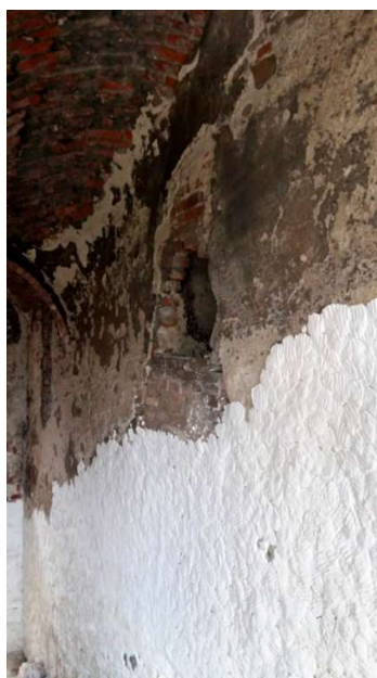
37. Týn nad Bečvou , hrad Helfštýn, 14. století, příklad odsolování zdiva pomocí buničitých zábalů
