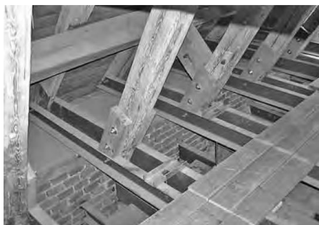
9. Jablonné v Podještědí , zámek Lemberk, 17. století, příklad použití ocelových konzol a příložek
