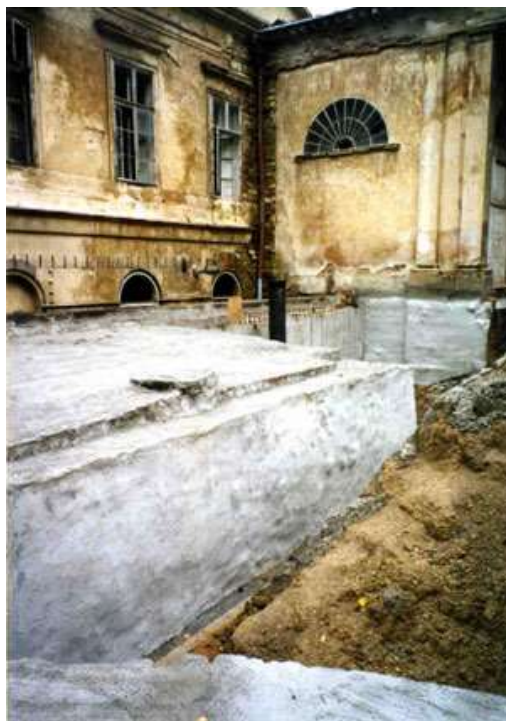
34. Praha , Letohrádek Kinských, 1. polovina 19. století, aplikace jílové izolace
