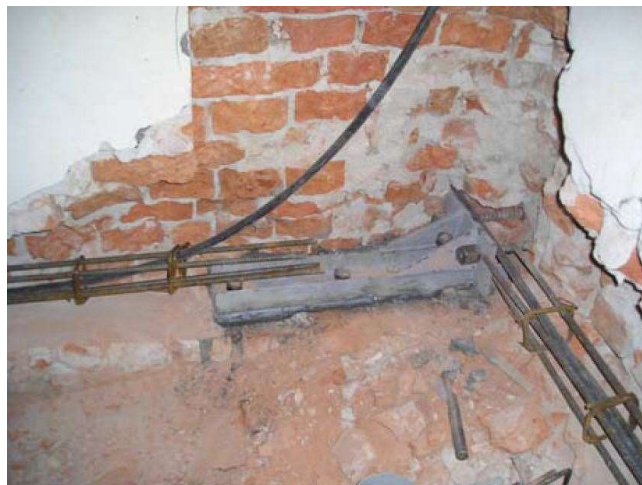
29. Ostrava , Ostravské muzeum, 19. století, kotvení ocelových táhel ztužujících stavbu
