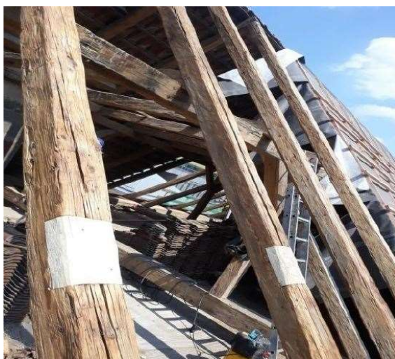
15. Praha , Dům u Hybernů, počátek 19. století, příklad plombování krokví krovu
