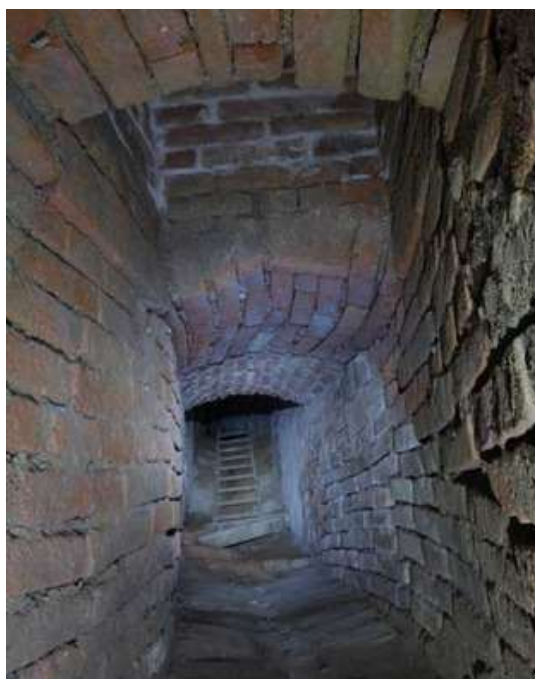
33. Praha , Klášter bosých karmelitek na Hradčanech, 1626, zděná větrací štola
