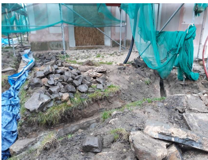
40. Horní Police , kostel Navštívení Panny Marie, 1718–1726, původní odvodňovací systém
