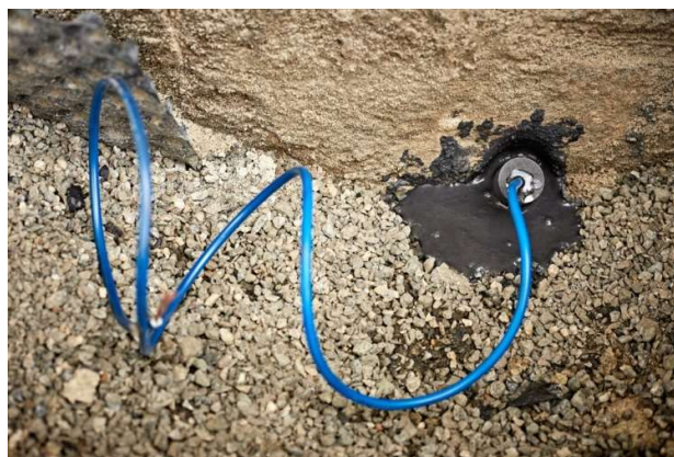
38. Kutná Hora , chrám sv. Barbory, konec 14. století, osazení katody při patě zdiva
