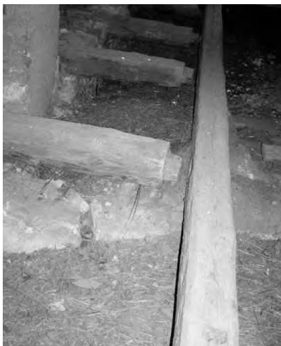
5. Strážov , tvrz Opálka, konec 14. století, porušení spojů krátčat a výměny
