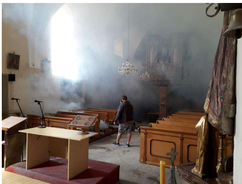
10. Neustupov , kostel Nanebevzetí Panny Marie, románský kostel přestavovaný v 16. století, příklad ošetření interiéru pomocí toxických plynů
