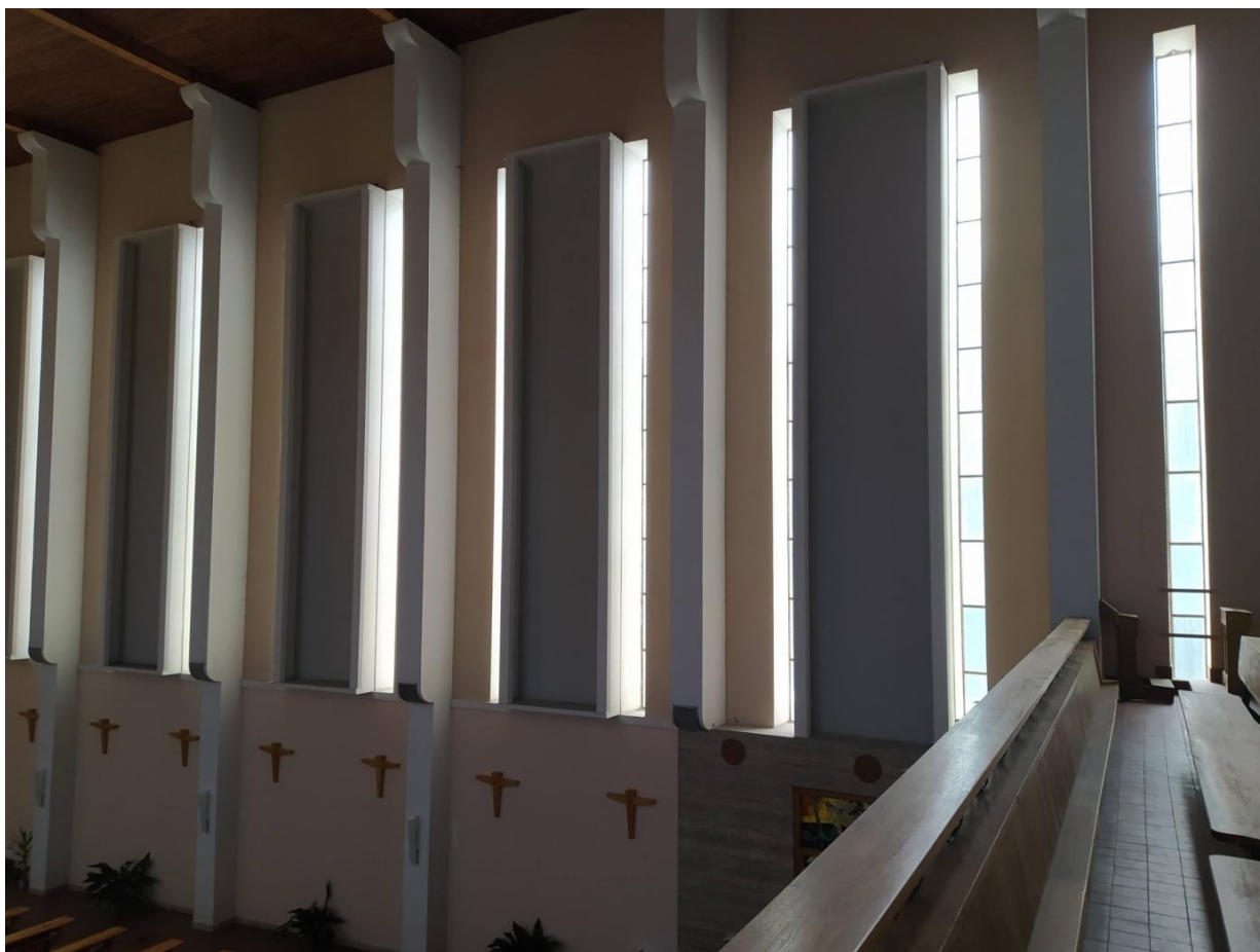
29. Praha-Košíře, pohled z empory na jižní stěnu lodi se štěrbinovými okny, kostel sv. Jana Nepomuckého. Foto: autor
