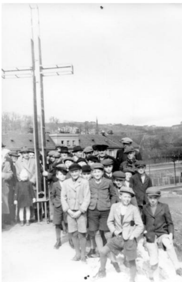
9. Fotografie z instalování kříže na věž kostela. Reprodukce z: Římskokatolická farnost u kostela Nejsvětější Trojice Praha-Košíře
