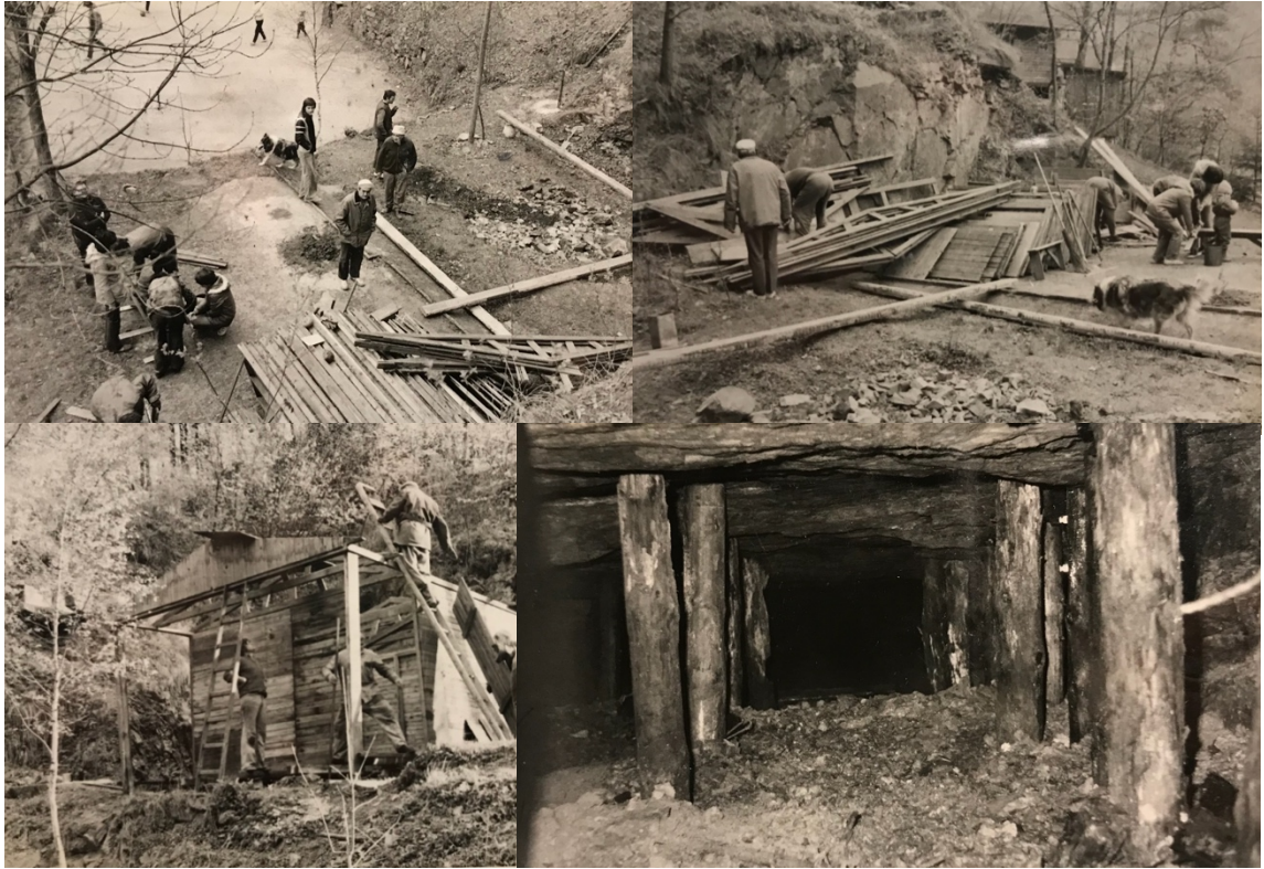
Stavba osadní chaty a průzkum ústí štoly sv. Barbory, r. 1981. Zdroj: Kronika osady Rychlá řeka 1947-1981.
