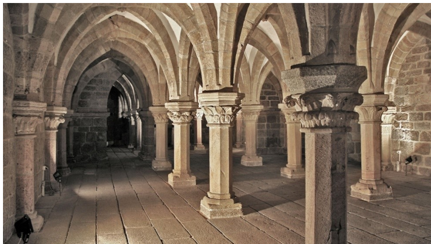
1c. Třebíč , bazilika sv. Prokopa, kolem roku 1240, krypta. Foto: autor
