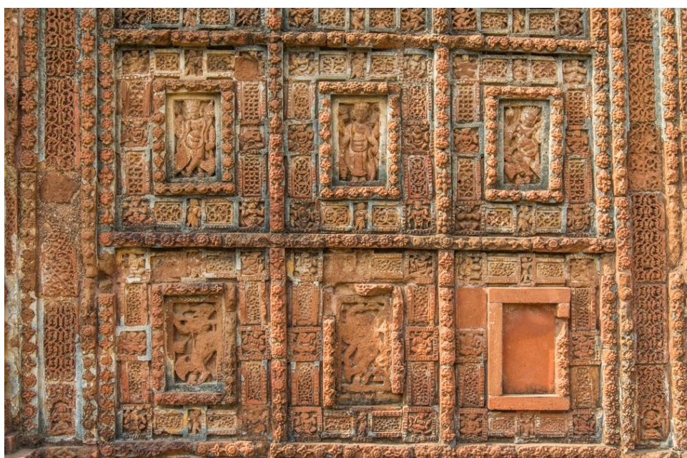
Obrázek 49: Detail části venkovní stěny chrámu Šjám Raj
