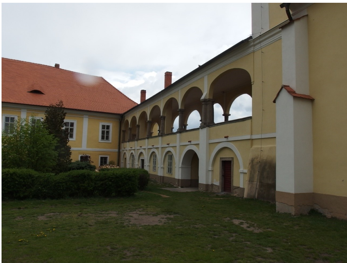
19. Nové Dvory, Zámek Nové Dvory, detail arkád
