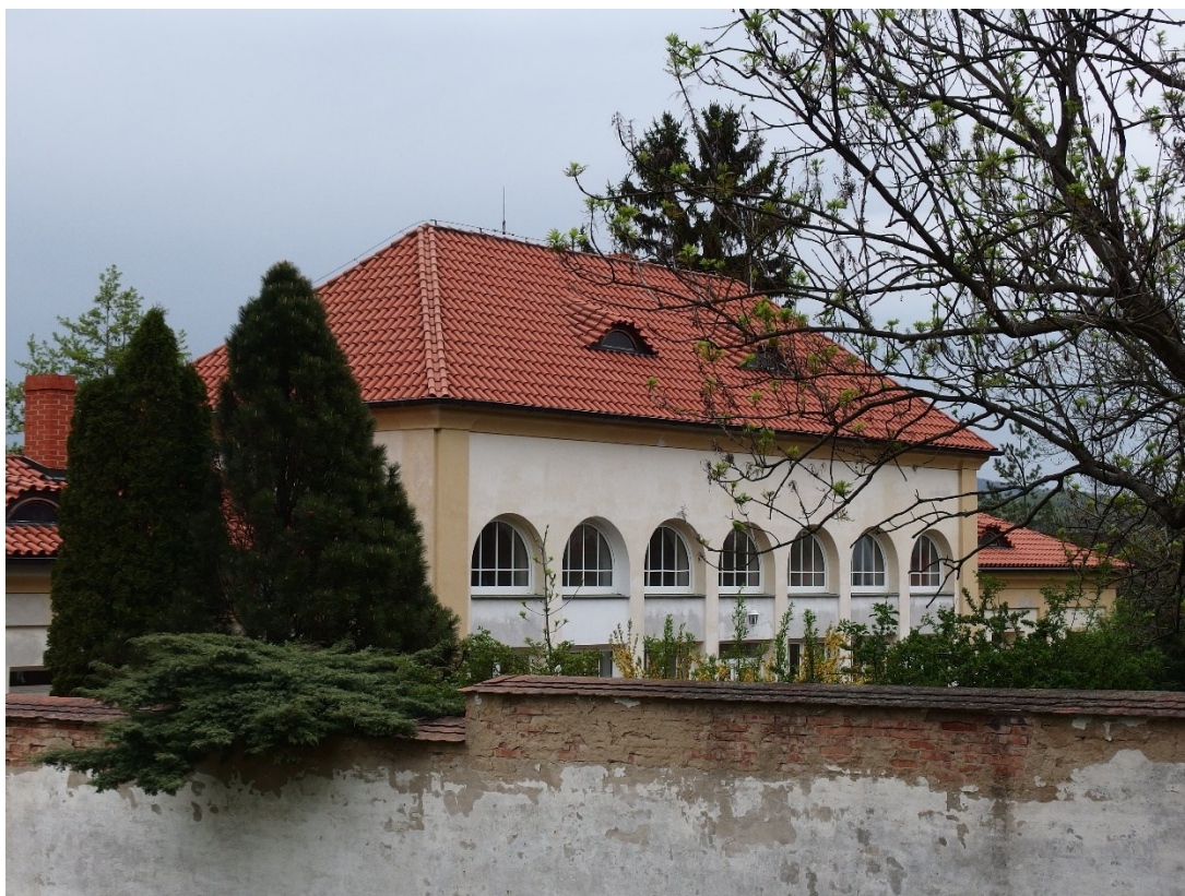
2. Bělušice, Tvrz Bělušice, pohled od západu, detail hlavní budovy
