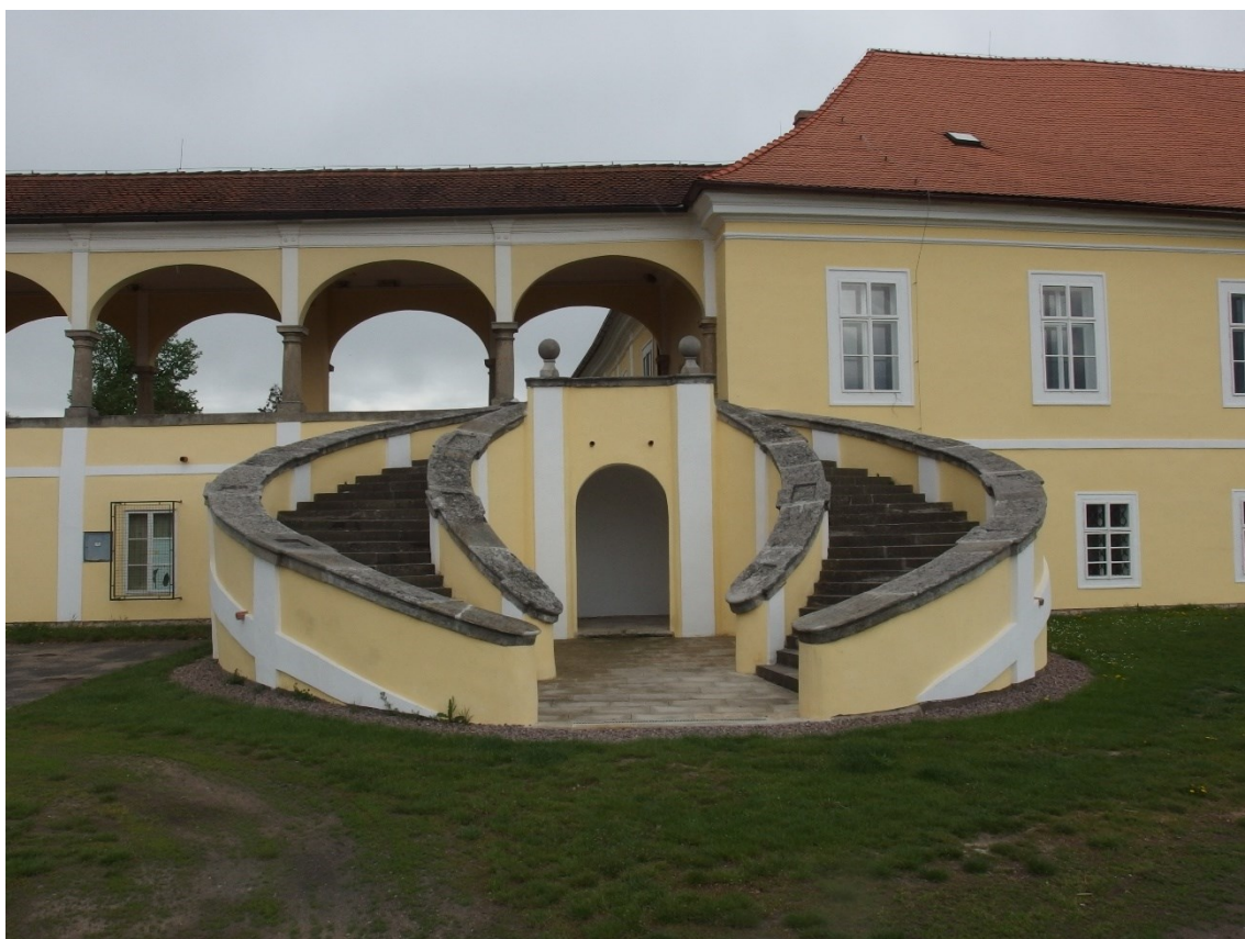
21. Nové Dvory, schodiště do bývalé zámecké zahrady
