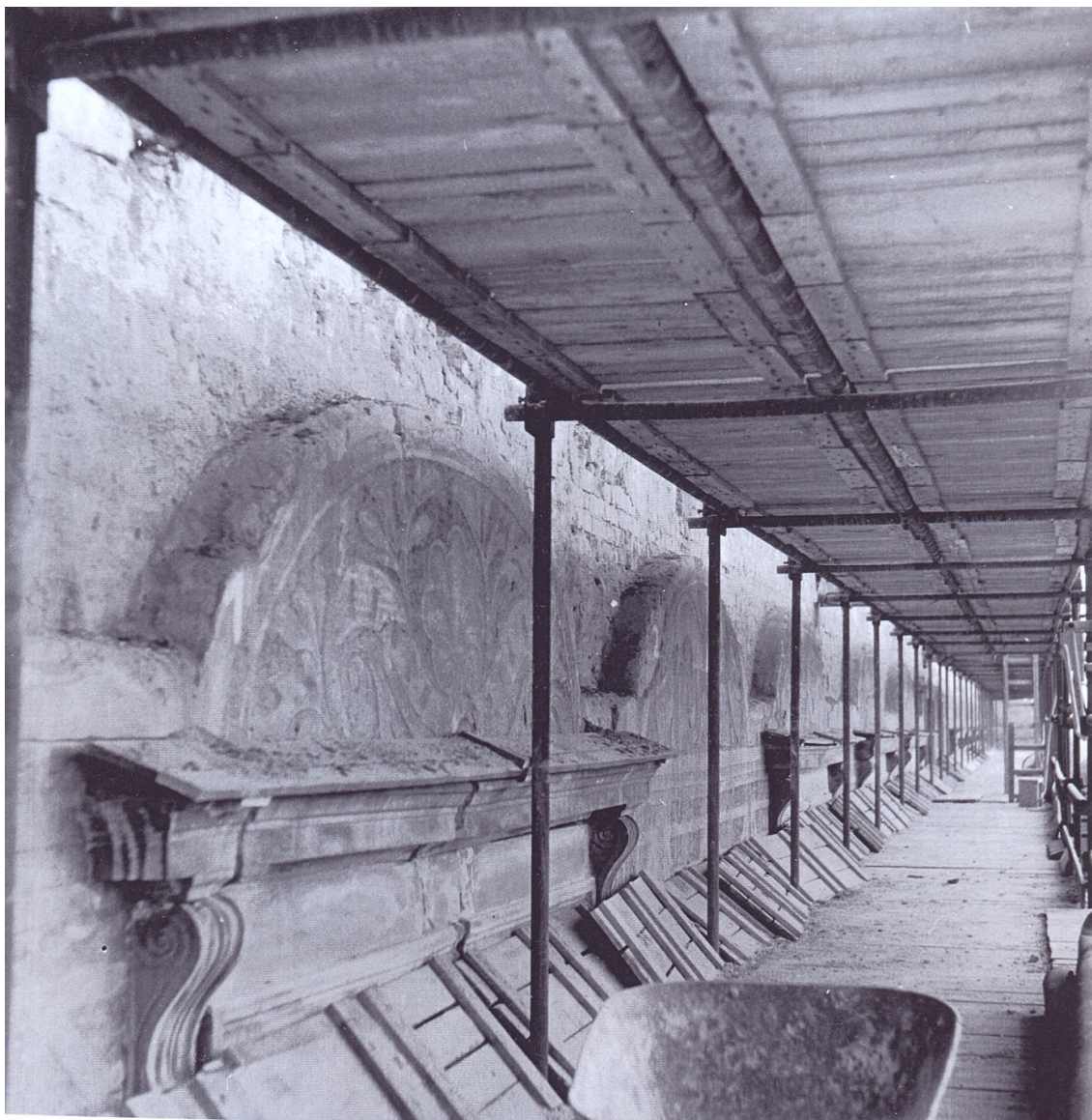
3. Pás lunet směrem od severu po snesení barokní přizdívky
