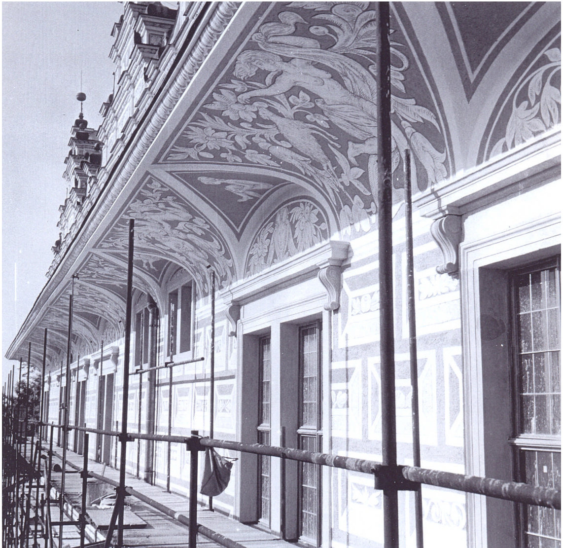
4. Lunetová římsa po rekonstrukci.
