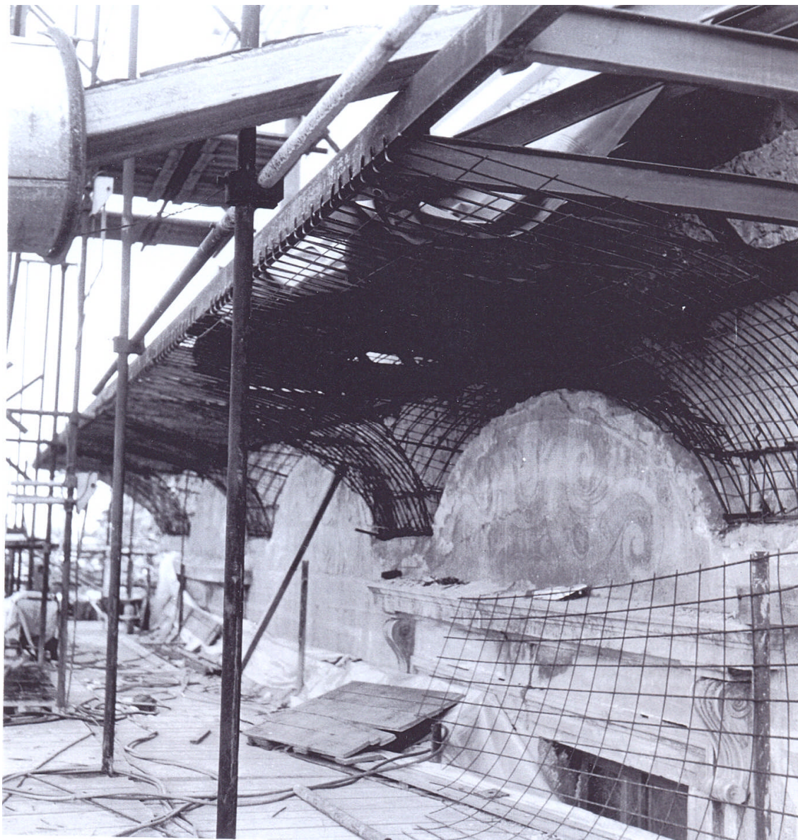
6. Severozápadní nároží – vyztužení stavební konstrukce.
