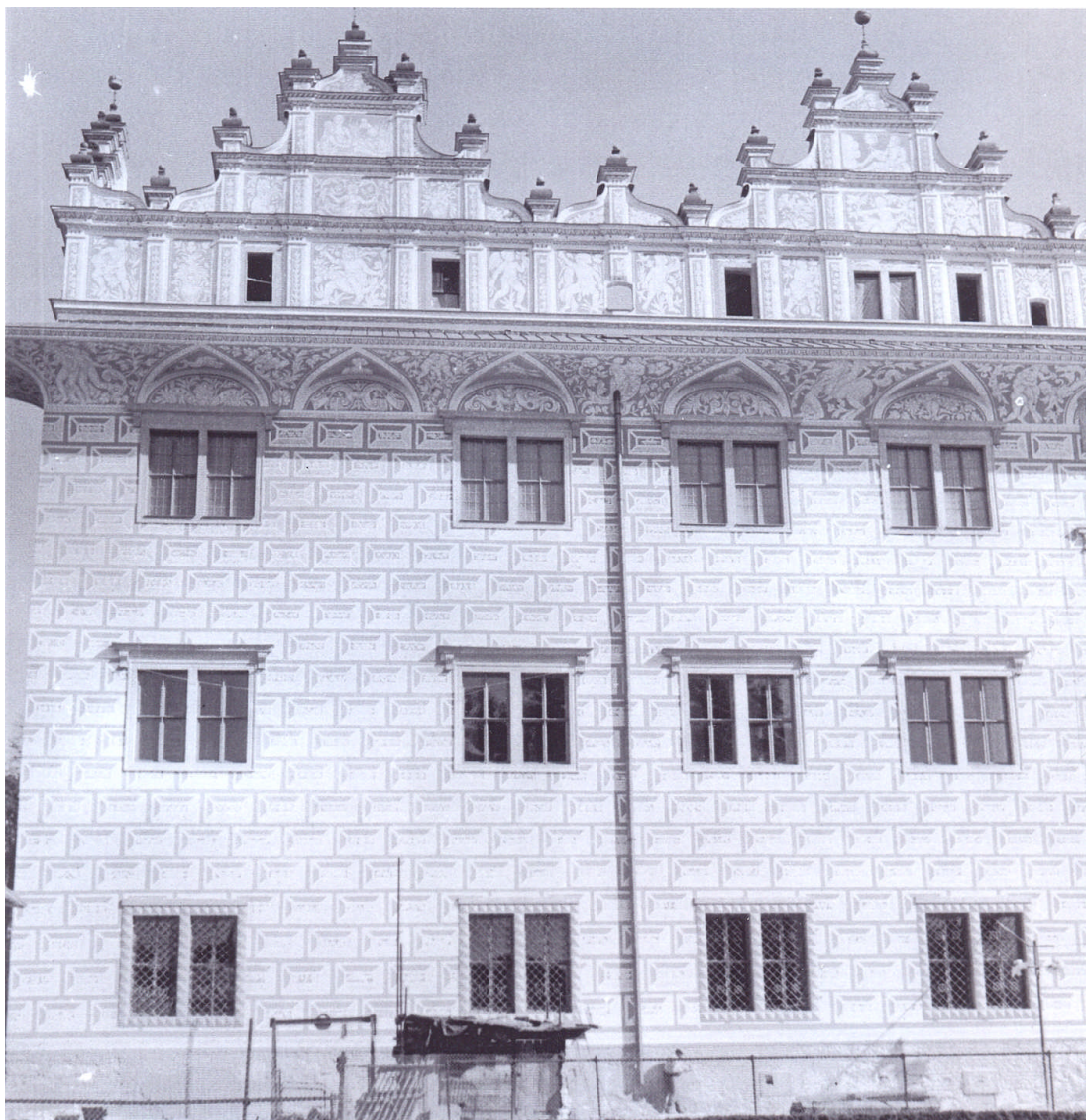
2. Západní průčelí, detail – výsledný stav.
