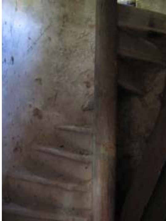
43. Původní barokní dřevěné šnekové schodiště, severozápadní rondel kaple sv. Máří Magdalény na Skalce, Mníšek pod Brdy.
