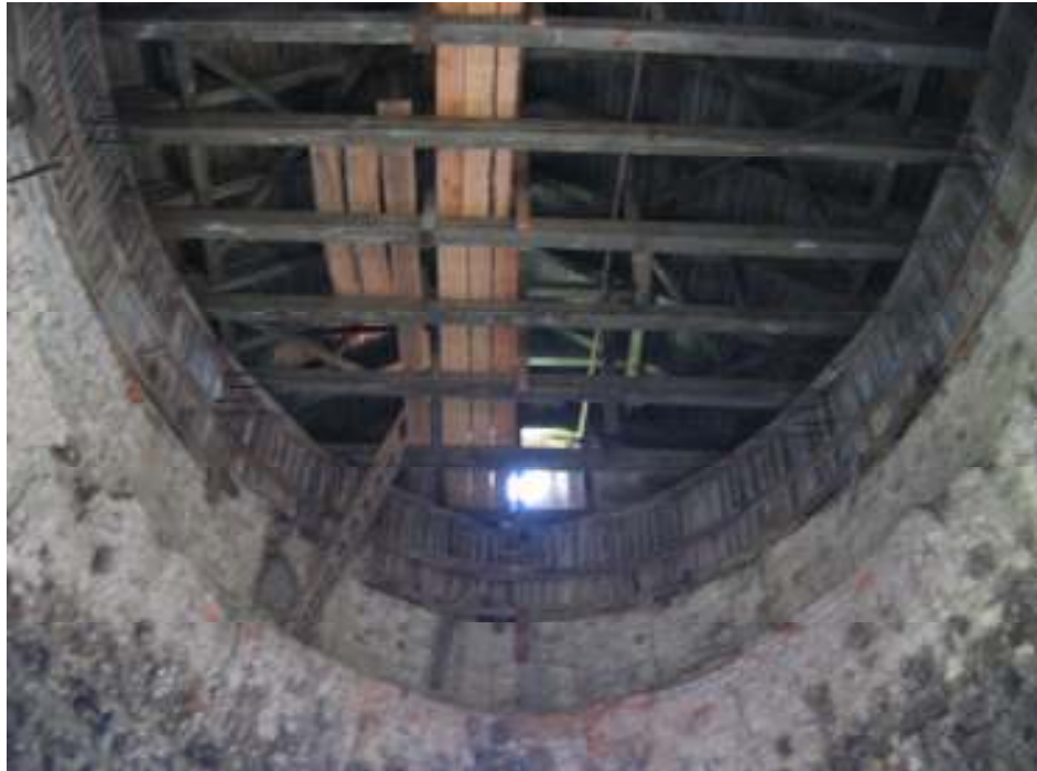
44. Současný stav oprav klenby kaple sv. Máří Magdalény na Skalce, Mníšek pod Brdy.
