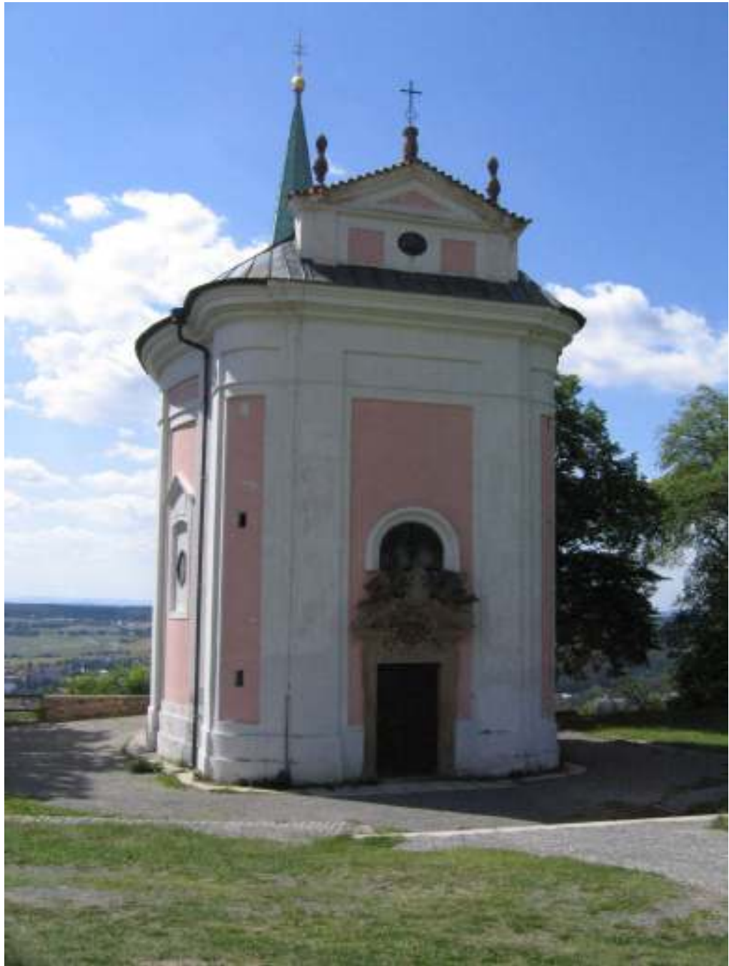
18. Kaple sv. Máří Magdalény na Skalce, hlavní průčelí, Kryštof Dientzenhofer, 1692–1693, pohled ze severu.
