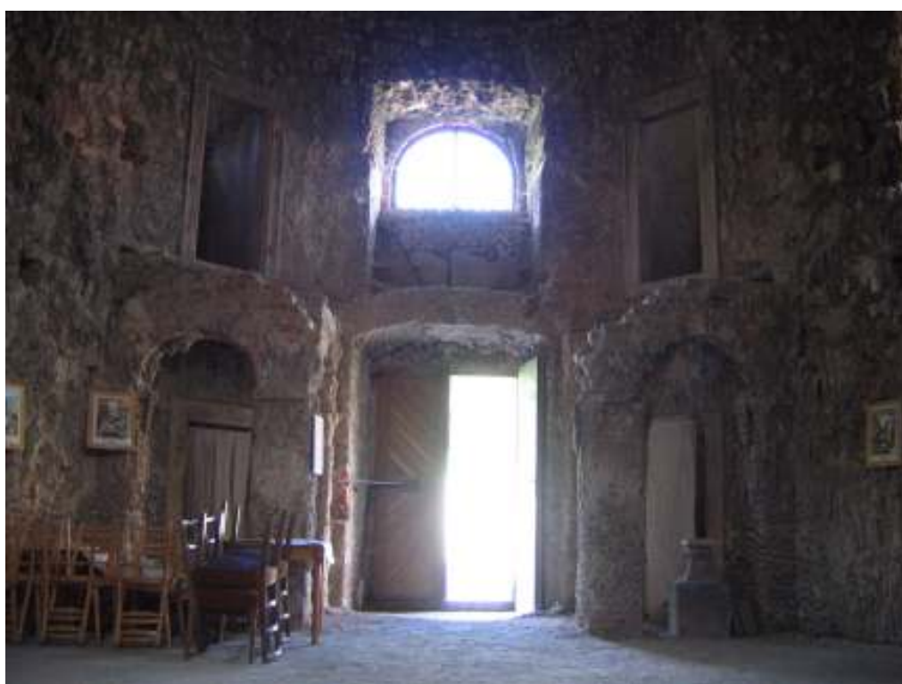
42. Severní vchod do kaple s pozůstatky kručty, kaple sv. Máří Magdalény na Skalce, Mníšek pod Brdy.
