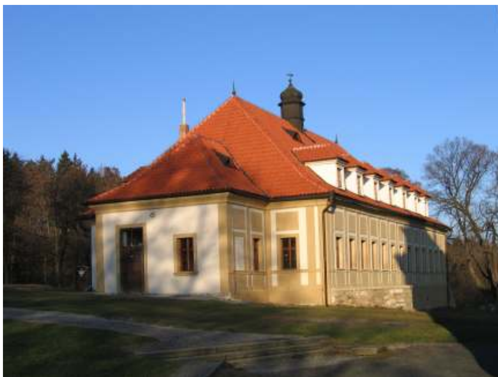
12. Budova kláštera, Skalka, Mníšek pod Brdy, Kryštof Dientzenhofer, 1692–1693, pohled od kostela z jihovýchodu.
