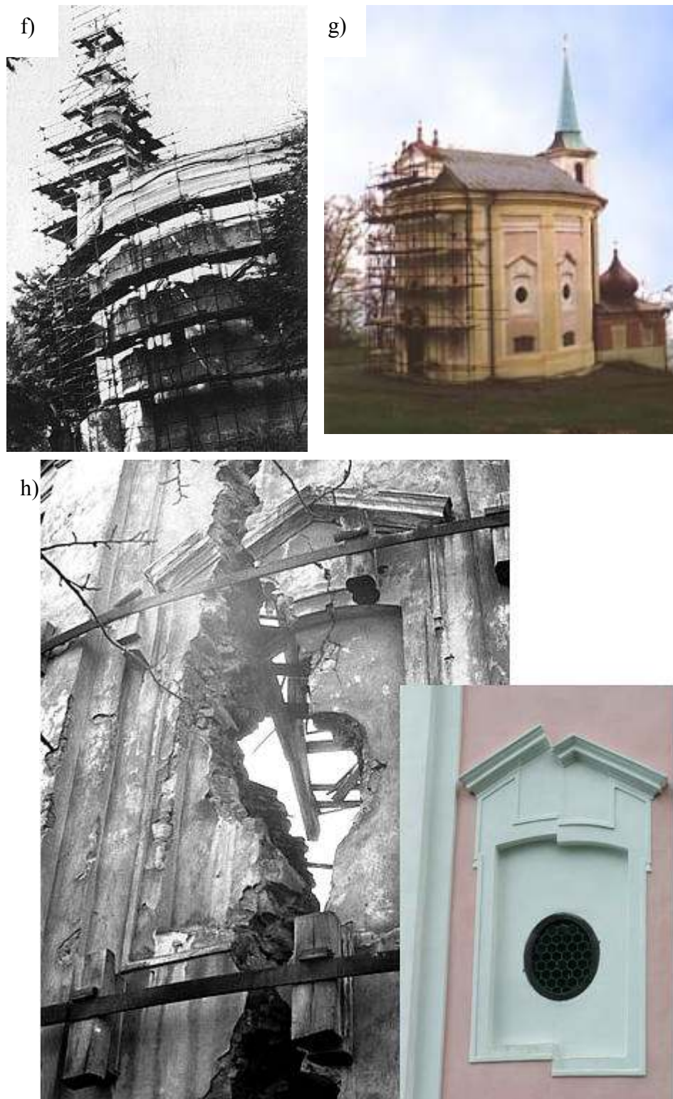
28. Fotografie kaple sv. Máří Magdalény na Skalce u Mníšku zachycující průběh jejich oprav během zhruba třiceti let: a) Skalecký kostelík v roce 1968 krátce po stažení zdiva obručemi, aby se zdi dále nerozestupovaly, b) část západního průčelí kostela s věží v roce 1971, c) Stav hlavního severního průčelí kostela v roce 1975, d) pohled na stále zdevastované východní průčelí, 70. léta 20. století, e) kostelík je opravován, 1983, f) stav oprav kostela v roce 1989, g) finální úpravy fasády v roce 1993, h) podoba okénka na východní fasádě kostela v sedmdesátých letech 20. století a dnes, v roce 2007.
