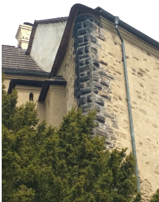
7. Loket , loketský hrad, původně věžovitý palác, zhotovený dvorskou hutí, ukázka nárožních armovaných bosovaných kvádrů, pohled z jihozápadu
