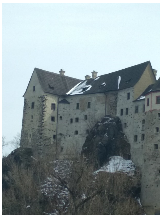
4. Loket , loketský hrad, pozůstatek druhé hradní věže přestavěné na palác (vlevo), ze zdiva vystupující rotunda (vpravo), pohled ze severozápadu
