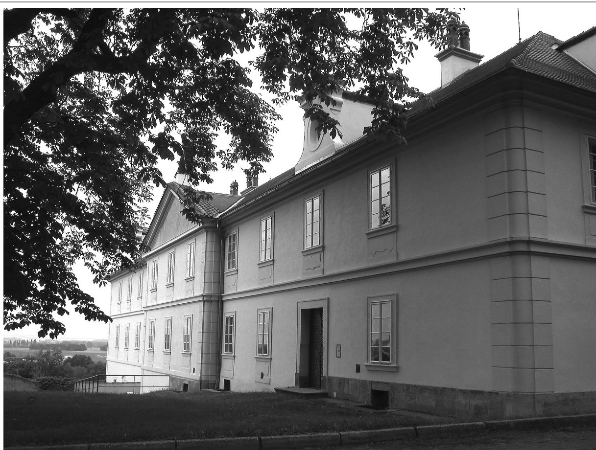
Obr. XXVII - Pohled na východní fasádu východního křídla bývalého konventu.
