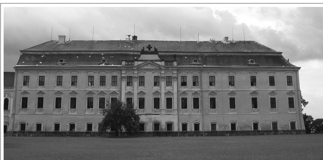
Obr. III - Pohled na severní průčelí hlavního křídla zámku v Lysé nad Labem.
