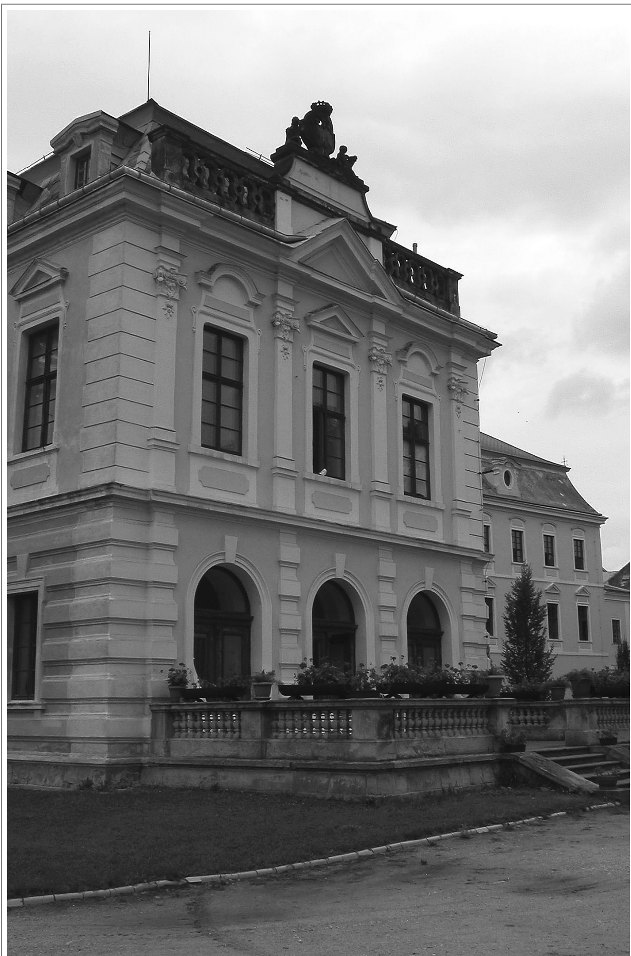
Obr. VII - Jižní průčelí zámeckého západního křídla s přistavenou terasou.
