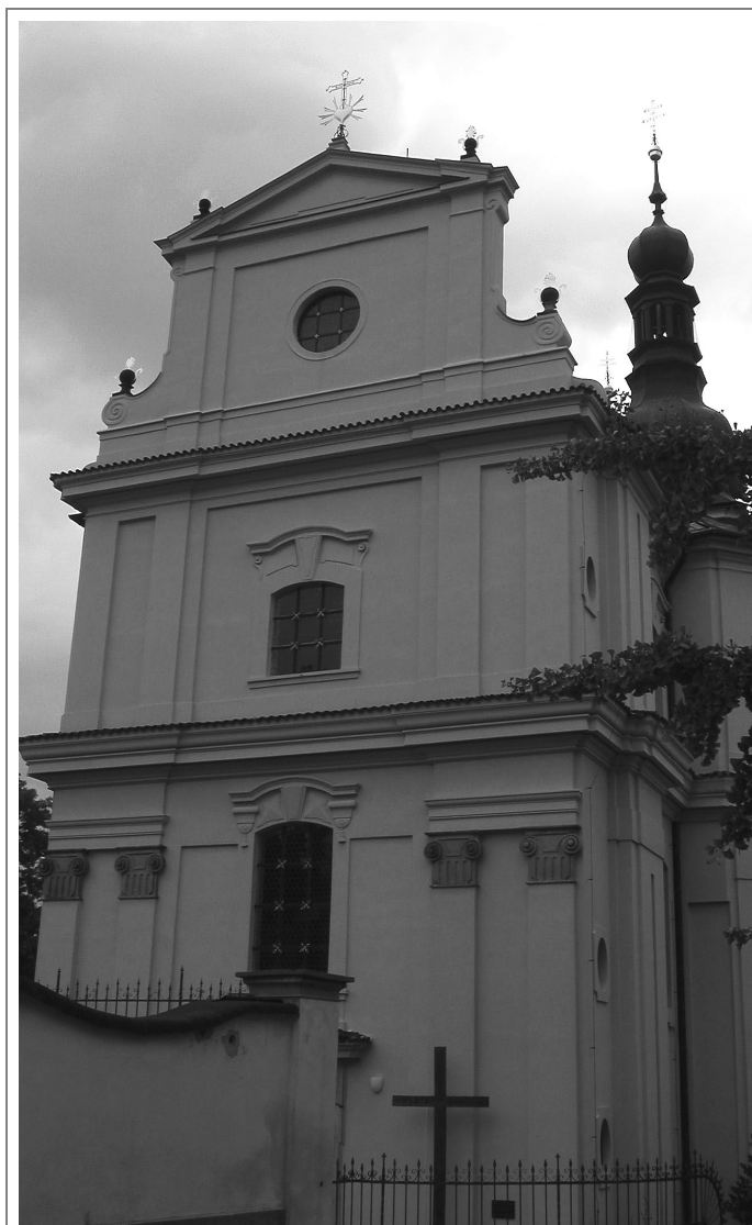
Obr. XXXI - Pohled na třítážové západní průčelí kostela sv. Jana Křtitele.
