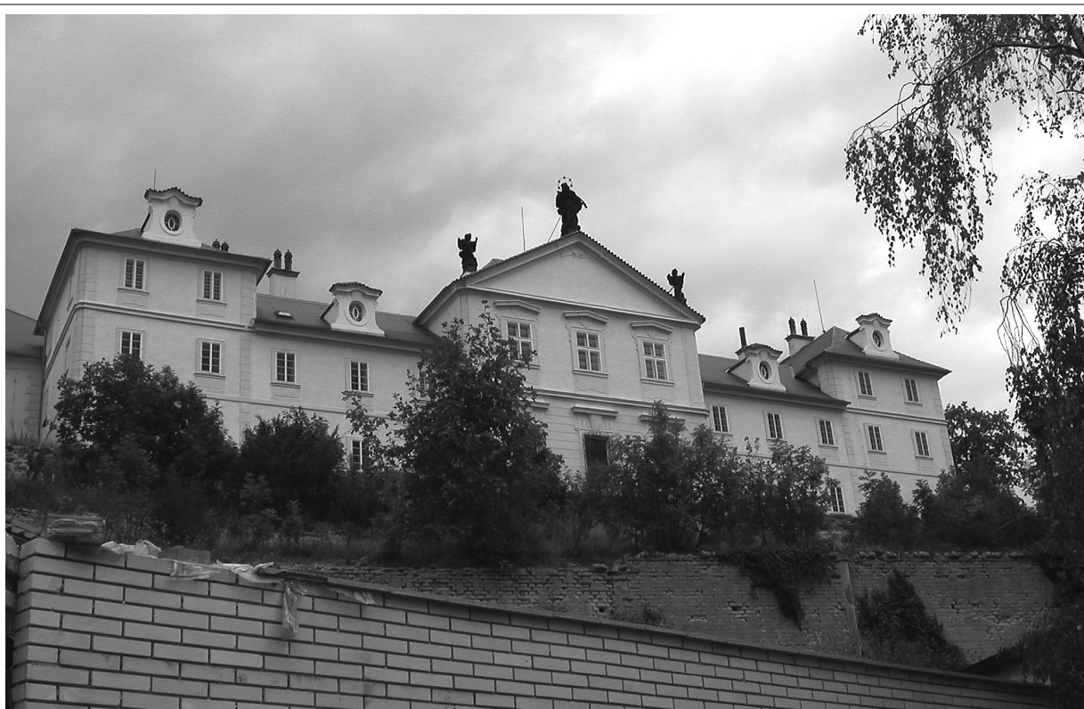
Obr. XXVI - Pohled na jižní fasádu jižního křídla budovy bývalého kláštera.
