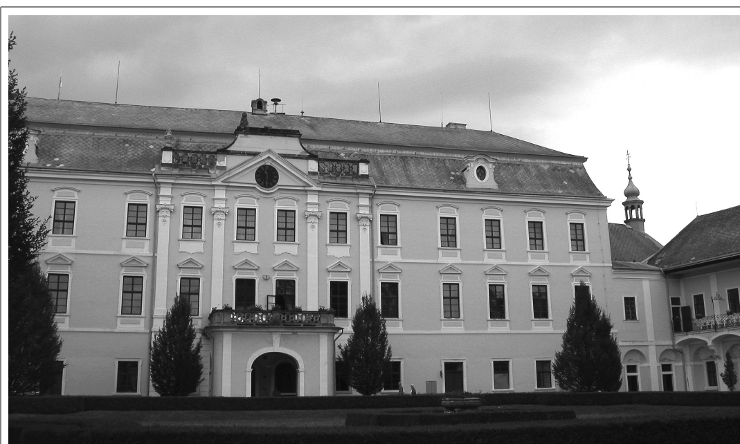
Obr. II - Pohled na jižní průčelí hlavního křídla zámku v Lysé nad Labem.
