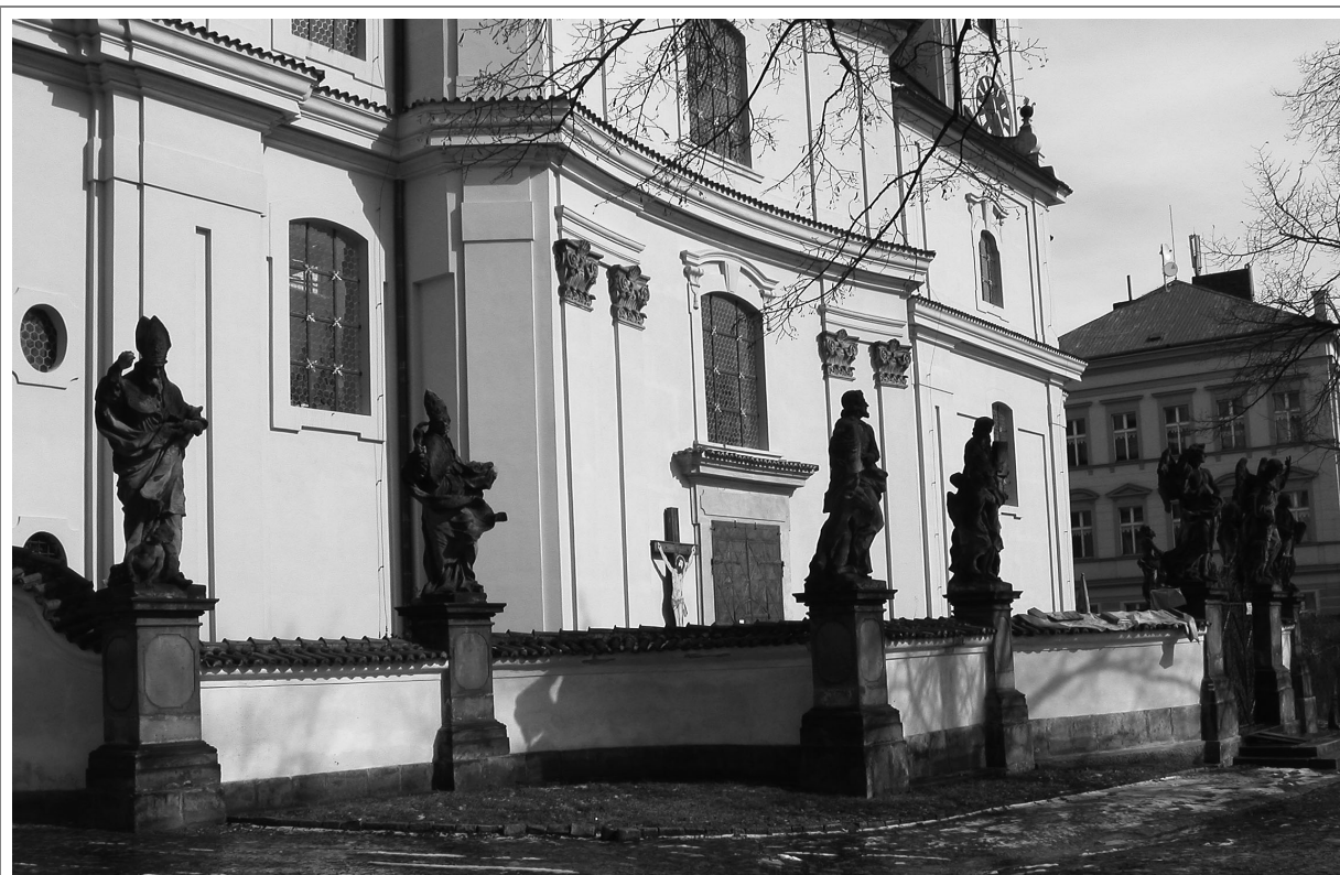
Obr. XXXVIII - Pohled na jižní průčelí kostela a na konkávně a konvexně zprohýbanou ohradní zeď kostela s dekorativními plastikami.
