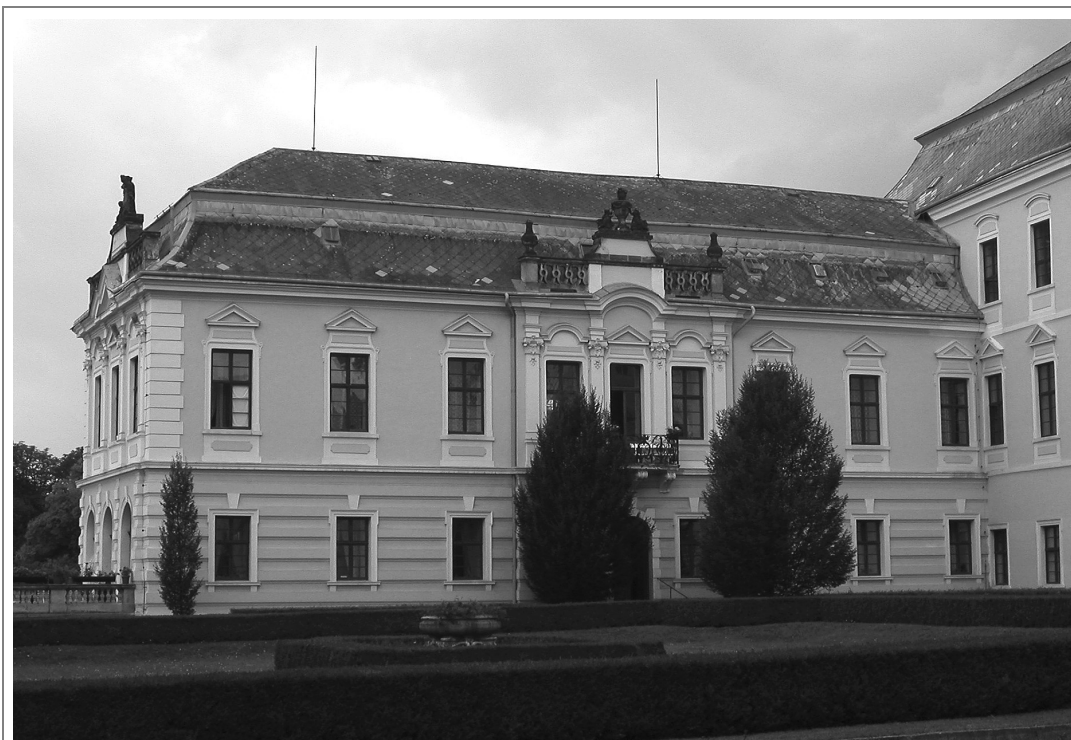
Obr. V - Nádvoří východní průčelí západního křídla lyského zámku.
