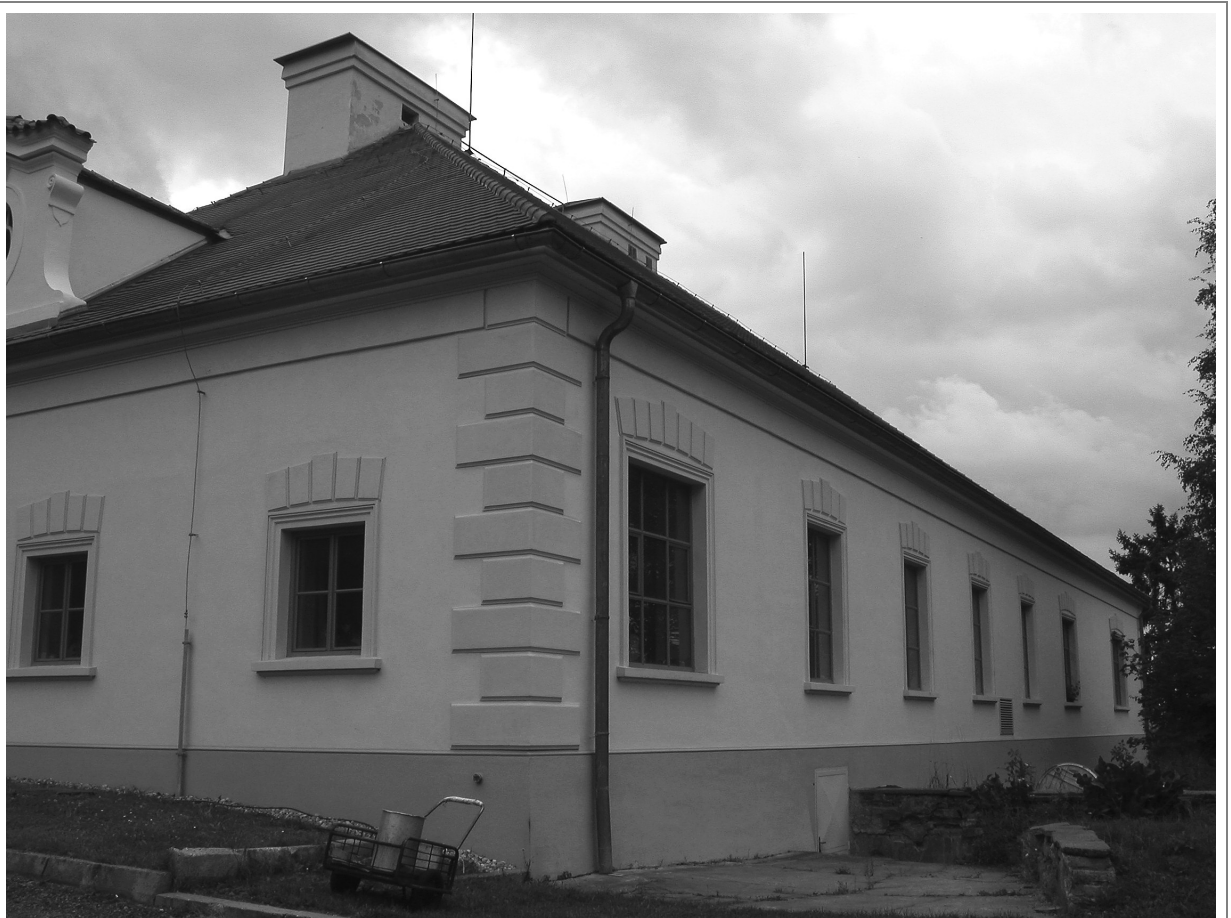
Obr. XXIX - Pohled na přízemní západní křídlo a na jeho západní průčelí.
