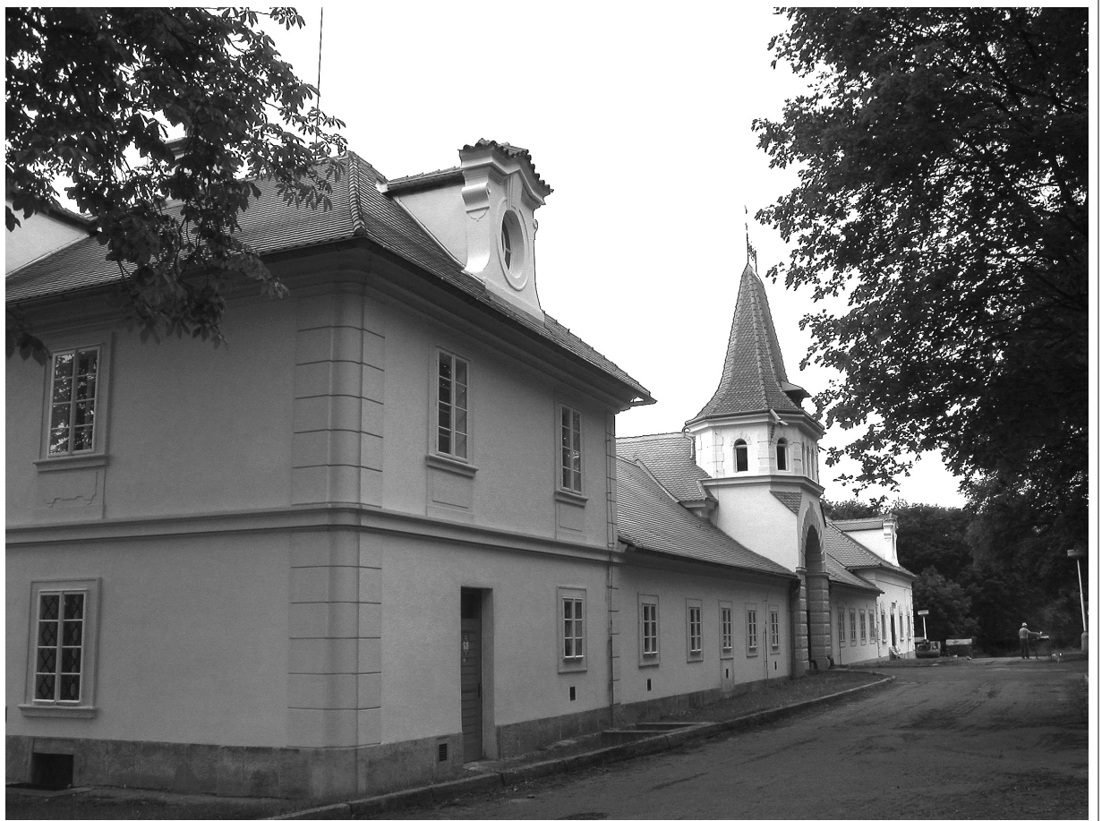
Obr. XXVIII - Pohled na severní křídlo konventu, na jeho severní fasádu obrácenou k zámku.
