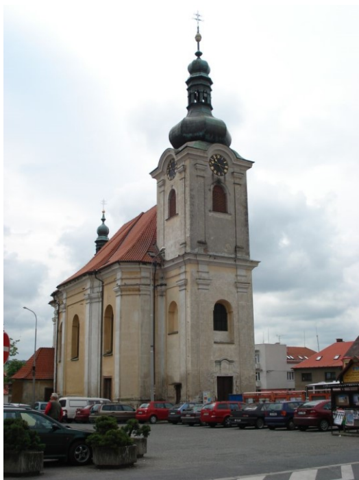
2. Uhlířské Janovice, kostel sv. Aloise, založen 1767, vystavěn 1794 – 1795, pohled na západní průčelí
