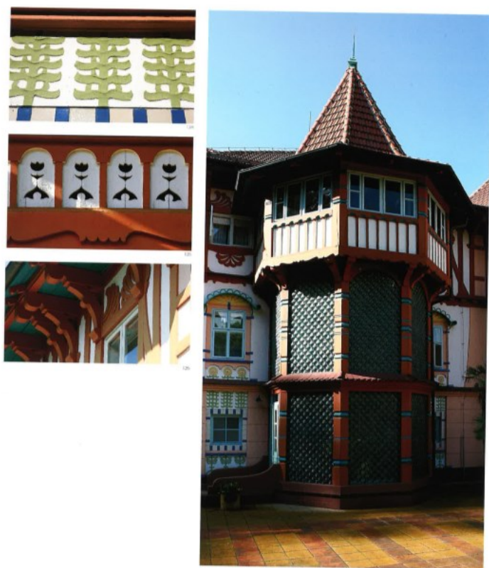
Janův dům v Luhačovicích, schodišťová věž. Zdroj: BOŘUTOVÁ, Dana. Architekt Dušan Samuel Jurkovič . Bratislava: SLOVART, 2009. ISBN 978-80-8085-665-6
