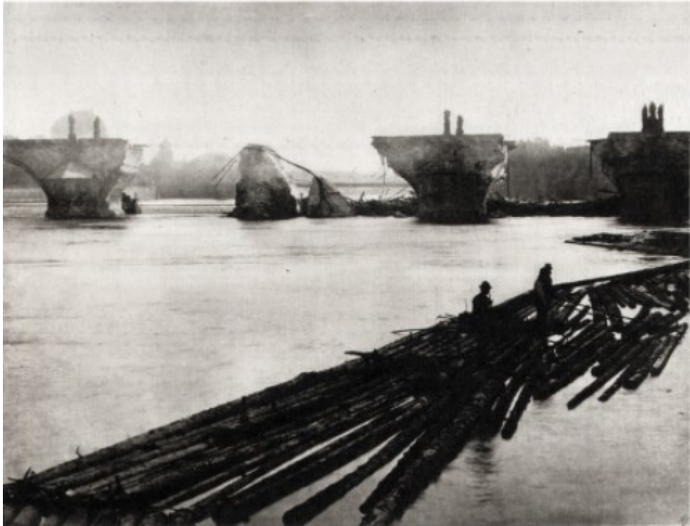
8) Pobořený Karlův most po povodni na podzim roku 1890
