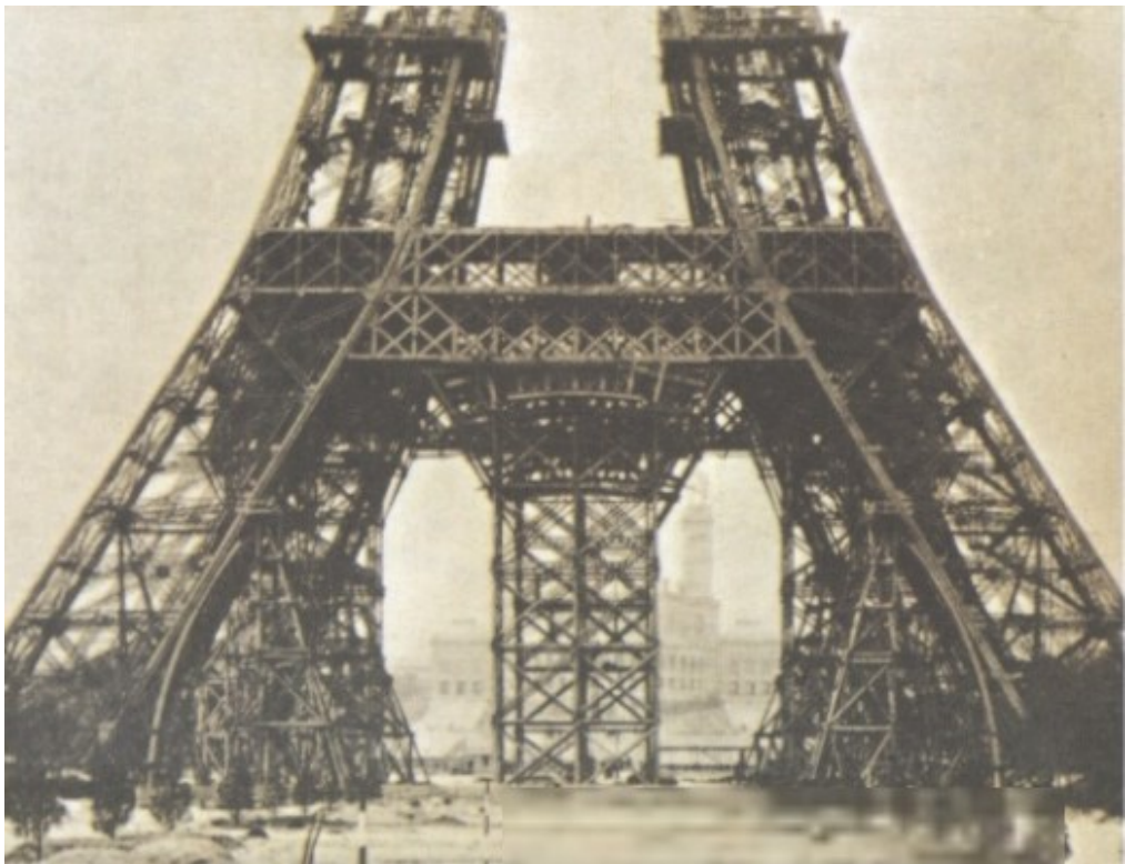
4) Detail stavby Eiffelovy věže v Paříži
