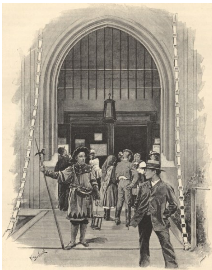
19) Detail vstupu do pavilonu KČT
