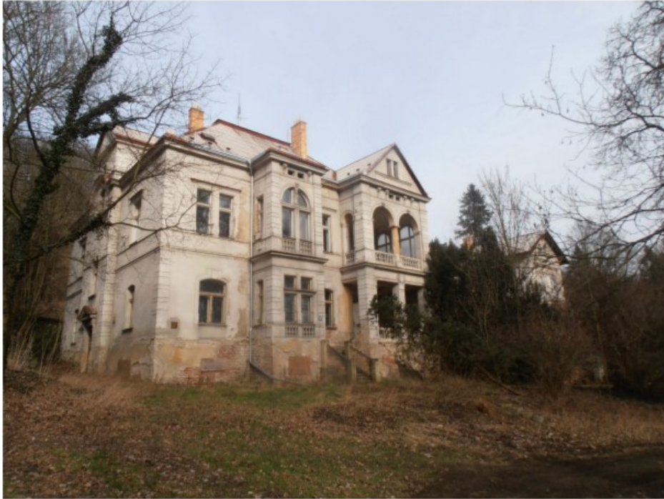
31 Josef Blecha, Haurowitzova vila, Tiché údolí 125, 1897, stav před rekonstrukcí
