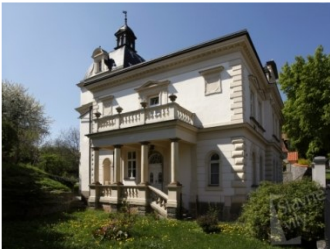
35 Dajbychova vila, Česká 103, 1884, dostavba 1898 – 1899
