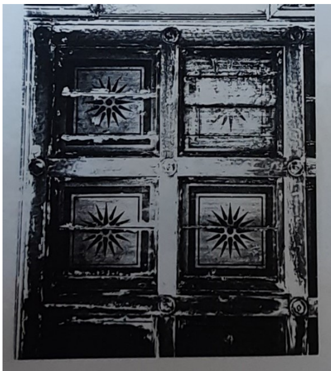
14 Dřevěný strop, stav v roce 1995, NPÚ, Průvodní technická zpráva k zaměření a vyhotovení dokumentace původního stavu, kazetový strop ve věži
