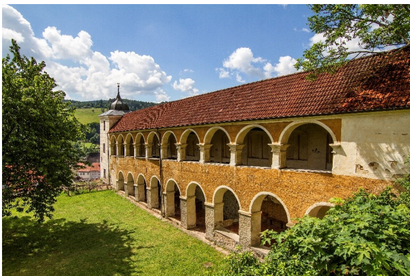
29. Arkádová lodžie v zahradě, pohled z východní části zahrady.
