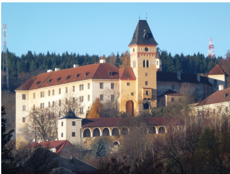
18. Horní zámek, pohled z východu ze směru hlavního vstupu.
