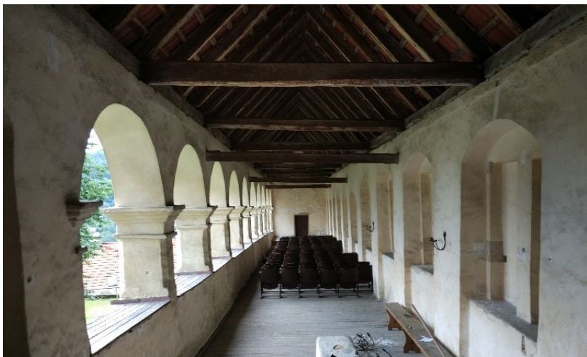
30. Arkádové lodžie, interiér prvého patra.
