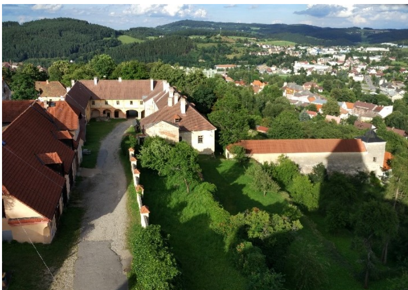
27. Pohled na první zámecké nádvoří z okna hodinové věže.
