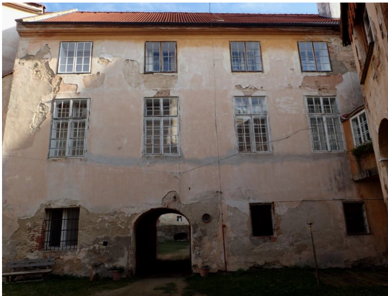
37. Příčné (kolovratské) křídlo Horního zámku, fasáda do třetího nádvoří.
