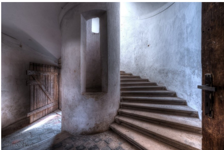
38. Příčné (kolovratské) křídlo Horního zámku, interiér, točité schodiště s dutým vřetenem.
