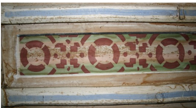
154. Zámek Vimperk, detail záklopné desky renesančního stropu nad prostory velkého sálu.
