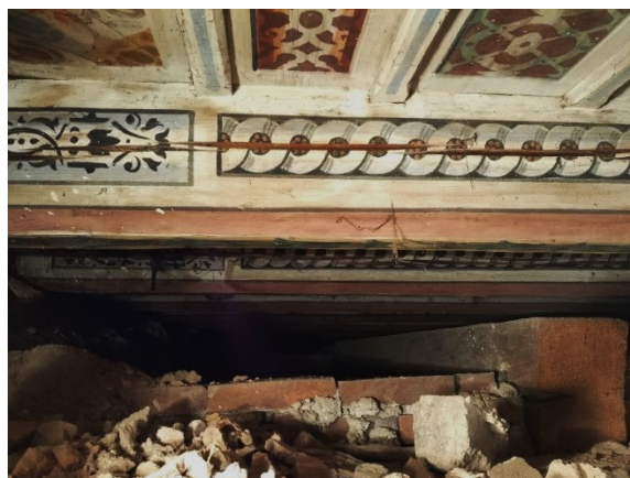
92. Místnost A , sonda v barokním podhledu s průhledem do prostoru s celistvě uchovaným renesančním stropem, prostory velkého sálu, jižní křídlo Dolního zámku.
