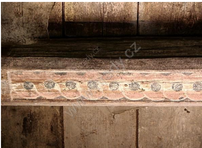
147. Tvrz Křepenice, detail záklopového stropu, motiv pletence zdobící trám obdobný vimperskému.
