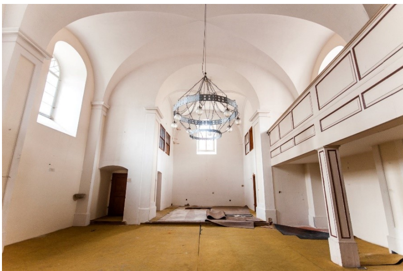
56. Kaple sv. Josefa na Horním zámku, interiér, stav před rekonstrukcí.
