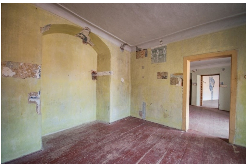
53. Severovýchodní křídlo Horního zámku, interiér druhého patra, třetí místnost renesančního apartmá, stav před rekonstrukcí.
