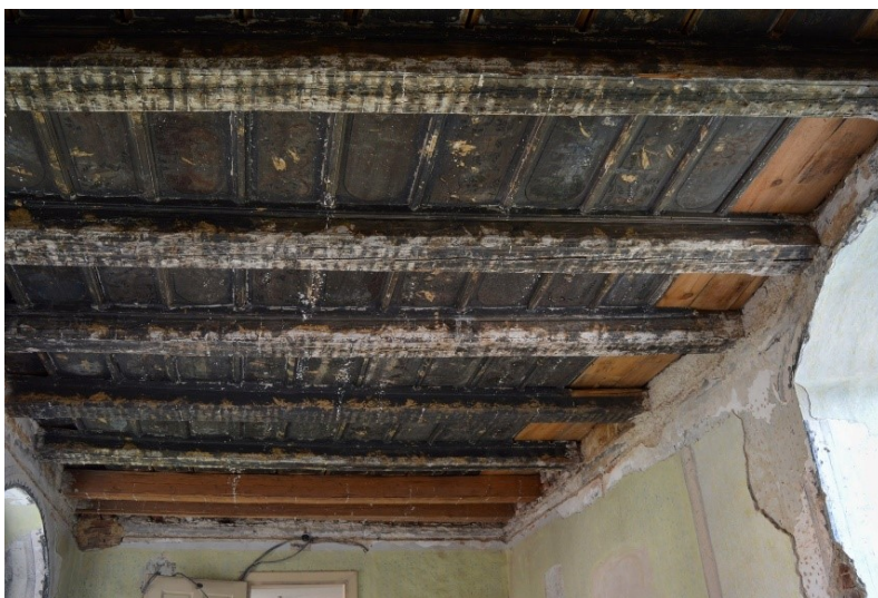
46. Severovýchodní křídlo Horního zámku, interiér druhého patra, renesanční apartmá, odkrytý renesanční malovaný zákloповý strop, datovaný po 1601.
