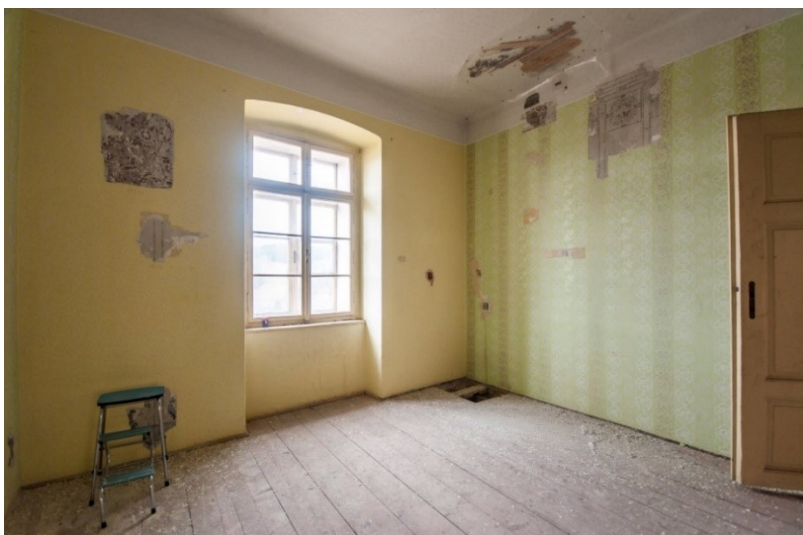
43. Jižního křídlo Horního zámku, interiér, stav před památkovou obnovou.
