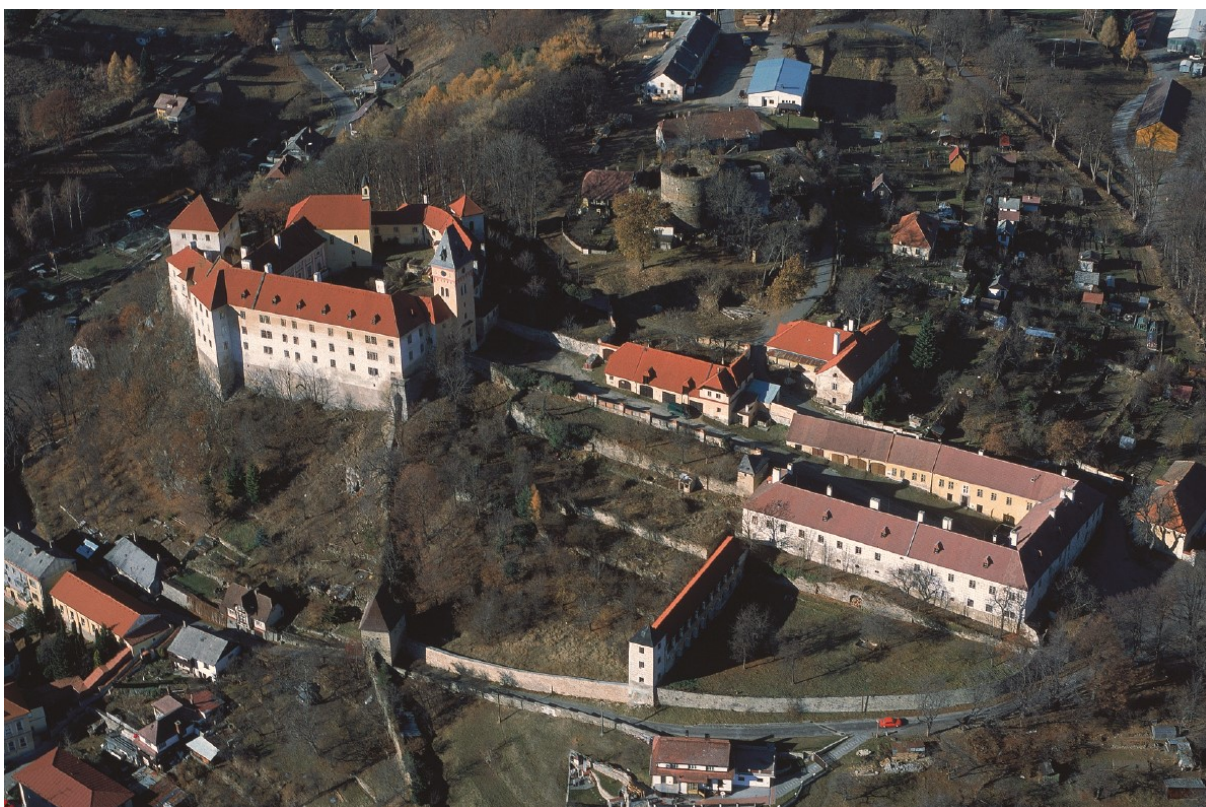
17. Letecký pohled na zámecký areál.
