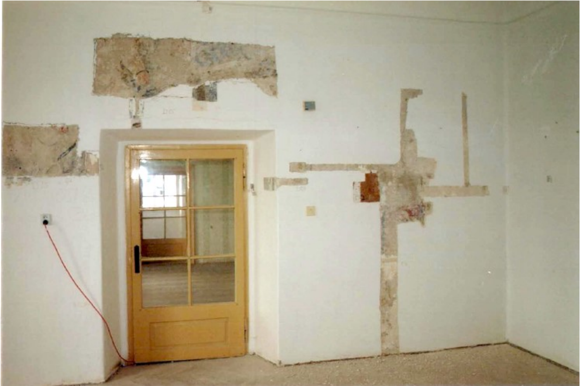
118. Místnost D , pohled na část západní stěny, prostory velkého sálu, jižní křídlo Dolního zámku.
