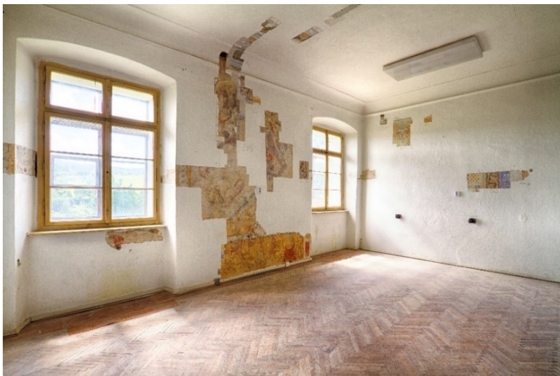
109. Místnost C , prostory velkého sálu, pohled na jižní a západní zeď, jižní křídlo Dolního zámku.
