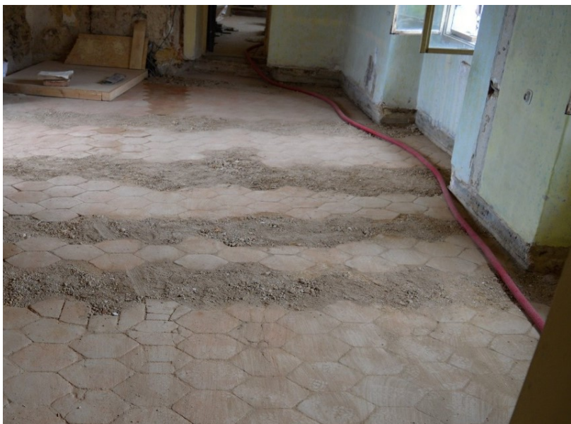
52. Severovýchodní křídlo Horního zámku, interiér druhého patra, renesanční apartmá, restaurátorsky doplněná a ošetřená renesanční dlažba.
