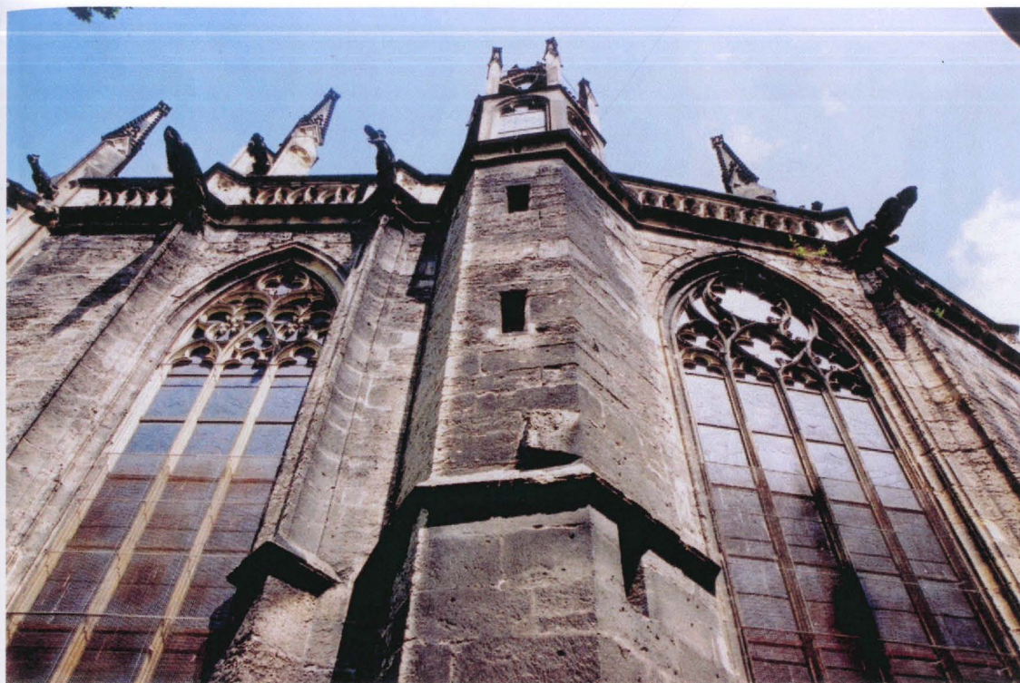
63. Věžice schodiště na chrámový ohoz
