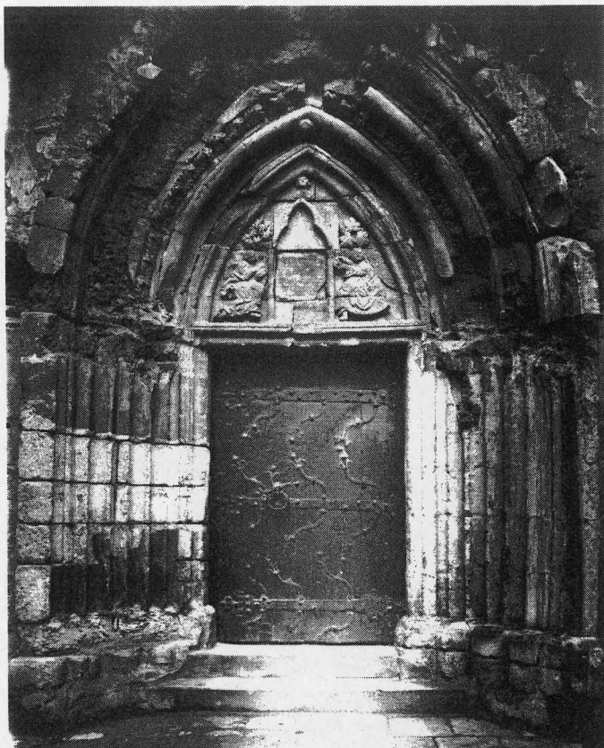
28. Hlavní severní portál, fotografie, 1906 – 7
