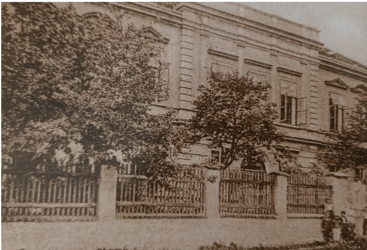
Obrázek 5 Škola po přestavbě a přístavbě 1. patra (zdroj: KAŠIČKA, František. Dolní Počernice. Praha, 2007, s. 98. ISBN 978-80-254-0110-1.).
