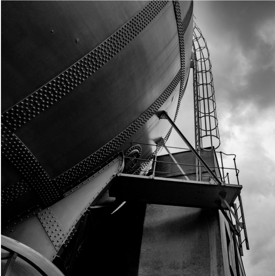
5. Konstrukce ochozu s krytým žebříkem.
