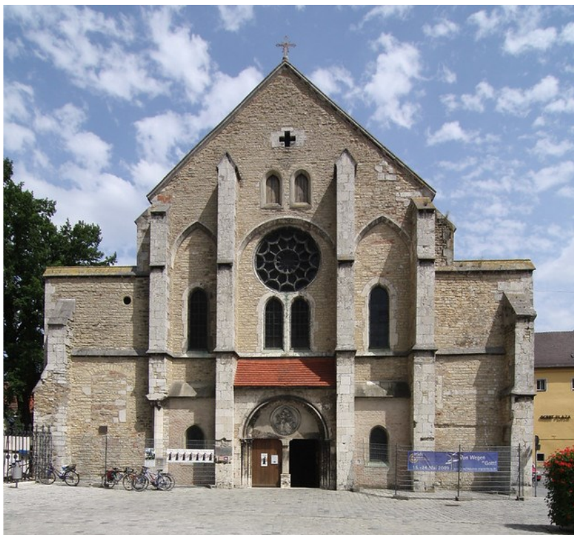
9. Řezno , dómský kostel sv. Ulricha, západní průčelí, před 1230, pohled od západu
