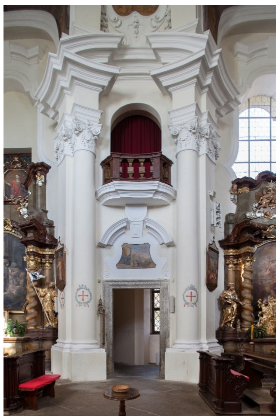
12. K. I. Dientzenhofer: Interiér kostela sv. Františka Xaverského v Opařanech, 1732–35, detail – vykláněné pasy nad vstupem do sakristie, pohled od jihu
