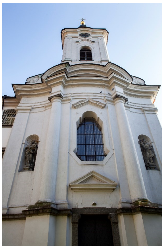
10. K. I. Dientzenhofer: Průčelí kostela sv. Františka Xaverského v Opařanech, 1732–35, pohled západu
