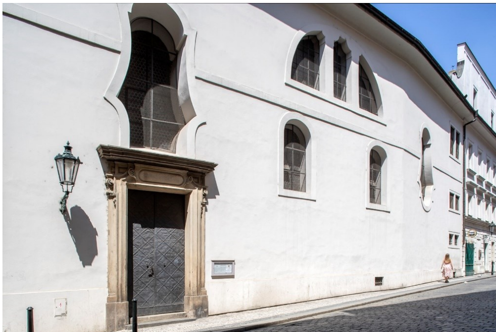
4. K. I. Dientzenhofer: Kostel sv. Bartoloměje v Praze, 1725–31, pohled od jihu
