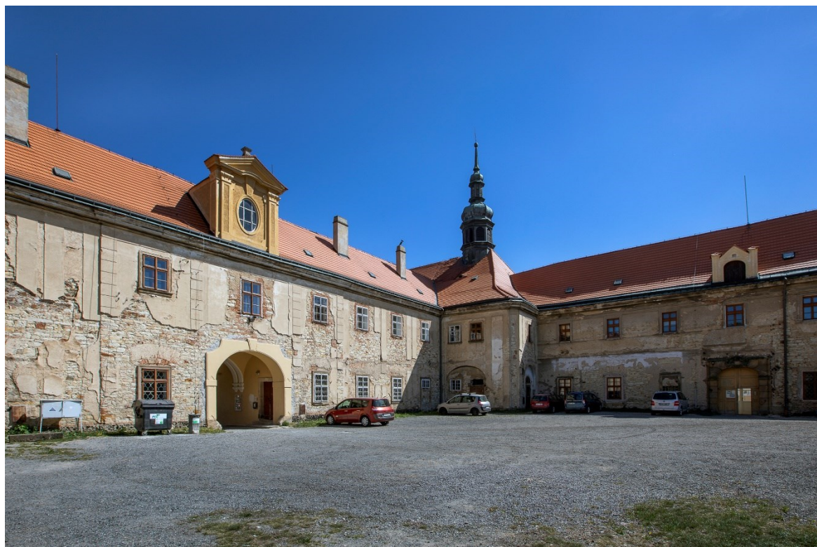
30. K. I. Dientzenhofer: Vstupní křídlo se závěrem kostela a částí hlavní budovy, Tuhoměřice, 1729–32, pohled od severozápadu
