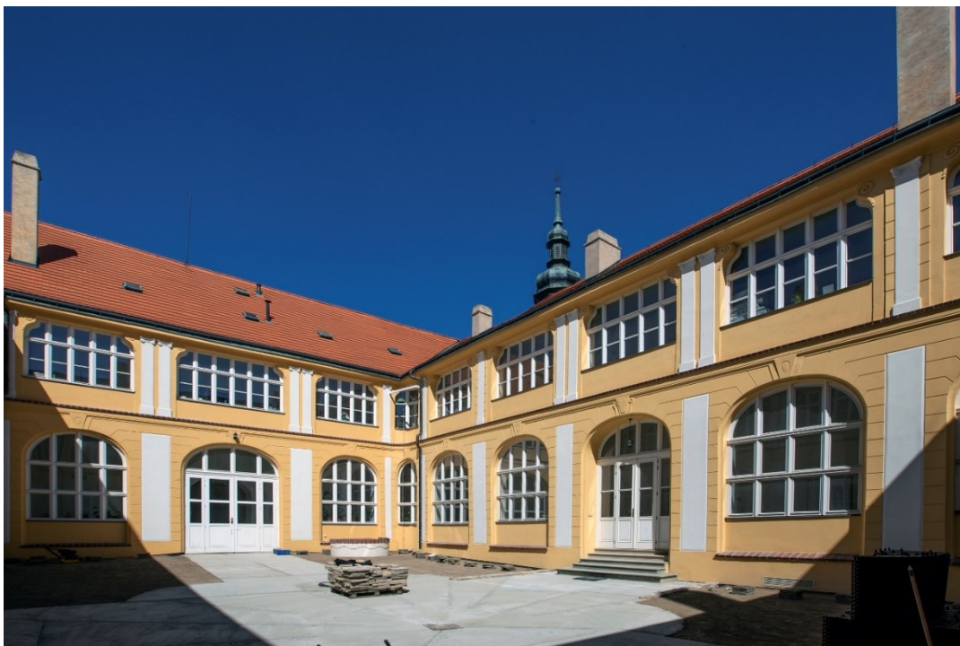
28. K. I. Dientzenhofer: Nádvoří chodbové traktů hlavní budovy rezidence, Tuhoměřice, 1729–32, pohled od jihozápadu
