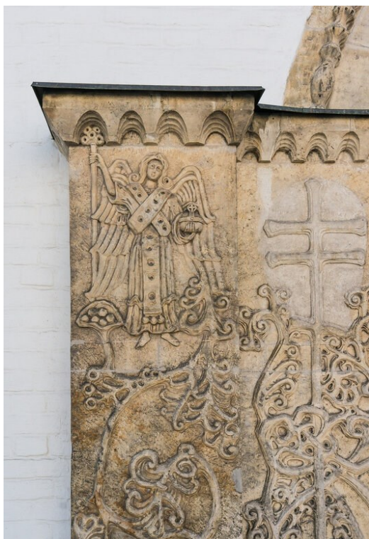
62. Velký portál, detail - anděl vlevo, severní přístavba Pokrovského chrámu Marfo-Marijského kláštera, N. Tamoňkin, 1909
