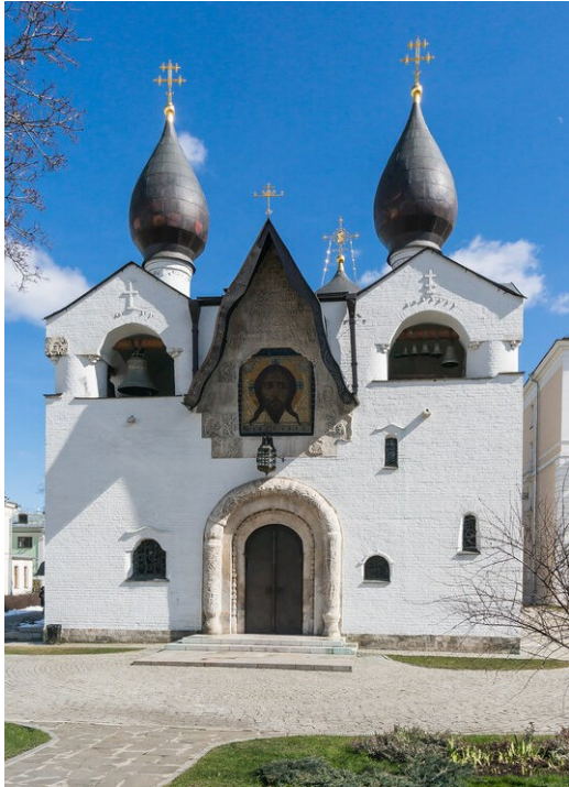
70. Hlavní portál , západní průčelí Pokrovského chrámu Marfo-Marijského kláštera, N. Tamoňkin, 1909
