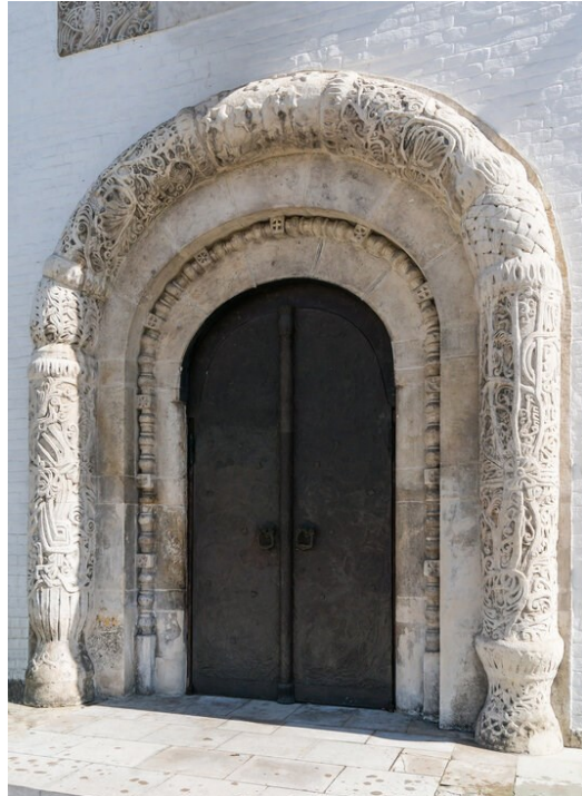
71. Hlavní portál , západní průčelí Pokrovského chrámu Marfo-Marijského kláštera, N. Tamoňkin, 1909
