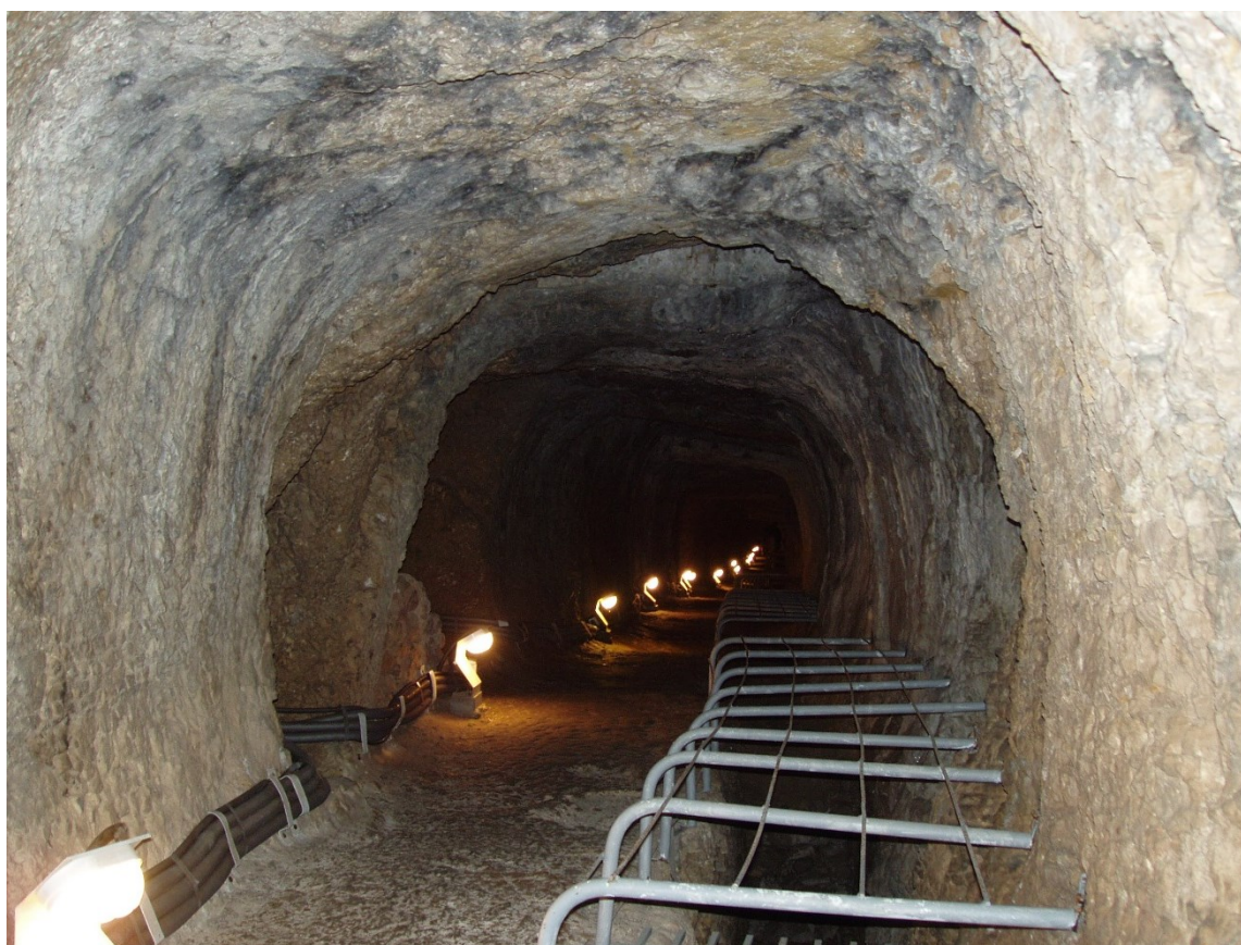
Obr. 92: Eupalinův vodovod na ostrově Samos, tunel. Polovina 6. století př. Kr.
