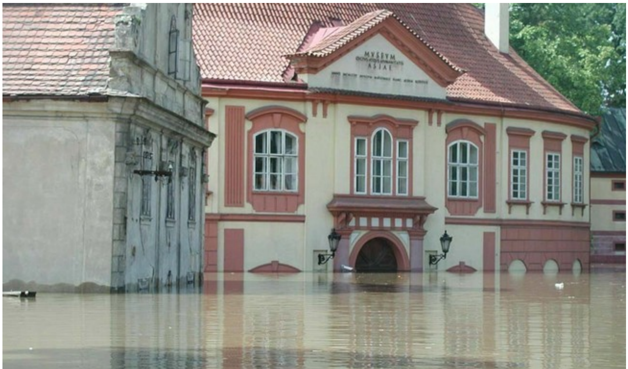
Příloha č. 10 a č. 11 – Město Liběchov a zámek v Liběchově (povodně 2002)
