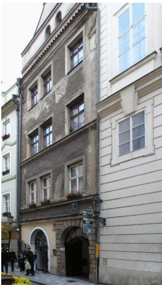
34. Praha , Karlova ulice, dům „U francouzské koruny“, pohled z ulice
