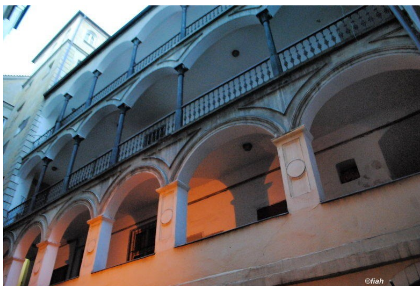
35. Praha , Karlova ulice, dům „U francouzské koruny“, pohled z arkádového dvora
