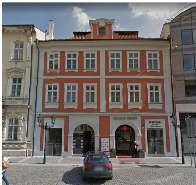
33. Praha , Ovocný Trh 12, dnešní podoba místa, kde se nacházela Václavská kolej
